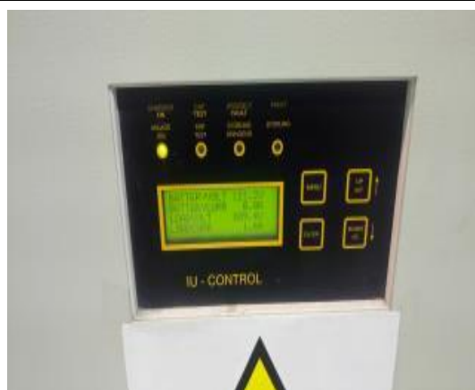
Fig. 102 Verificación de los parámetros Eléctricos en el cargador de batería 110 VDC.
