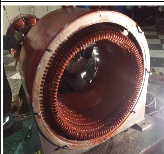
Fig. 118 Barnizado de Estator del Generador Eléctrico
