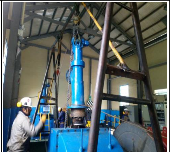
Fig. 70 Retiro de Inyector Superior
