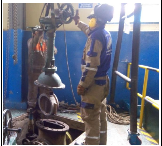
Fig. 68 Retiro de Válvula Principal
