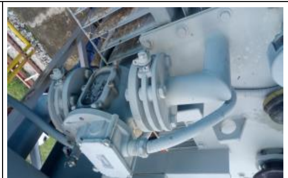
Fig. 109 Pruebas de accionamiento del Relé Bucholz.
