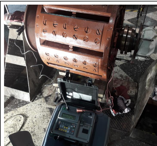
Fig. 65 Medición de Resistencia de Aislamiento del Rotor
