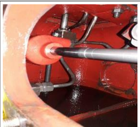
Fig. 87 Tuberías de Conexión del RR.VV.
