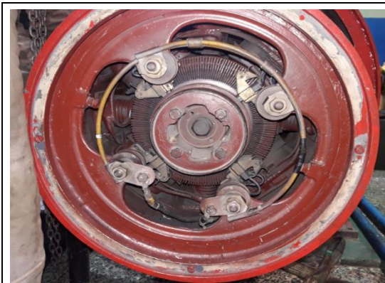
Fig. 50 Estator del Sistema de Excitación
