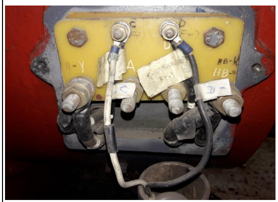
Fig. 49 Desmontaje de porta escobillas del colector.
