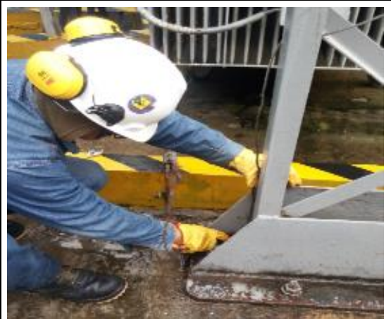
Fig. 107 Verificación de aterramiento del Transformador
