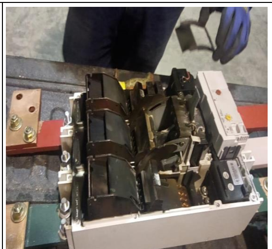
Fig. 97 Interior del Interruptor de Potencia
