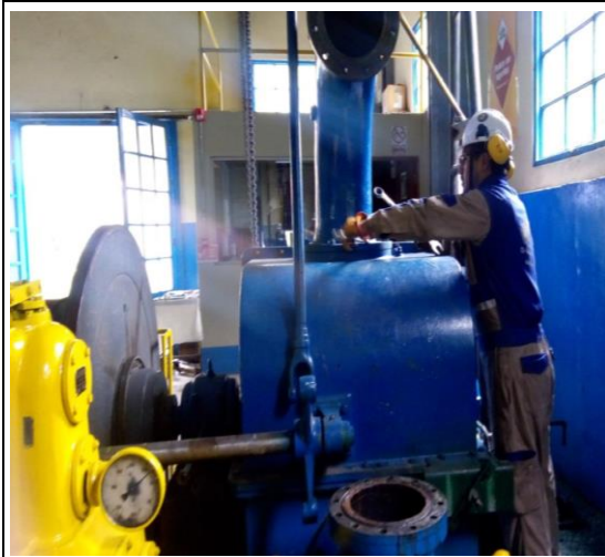
Fig. 69 Desajuste de pernos de Inyector Superior
