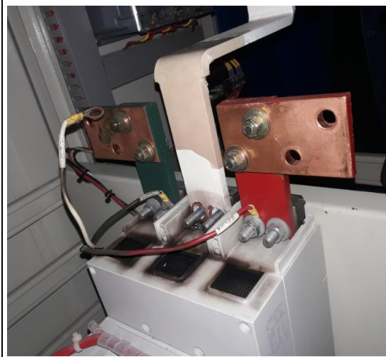
Fig. 95 Barras de alimentación
