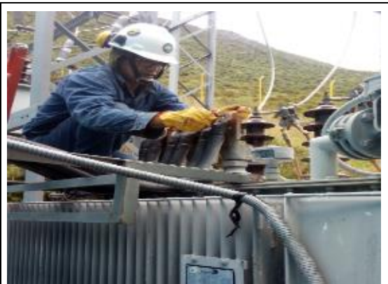
Fig. 105 Cortocircuito de los bushing de baja para realizar el megado.
