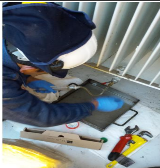
Fig. 151 Toma de muestra de aceite
