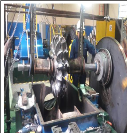
Fig. 129 Montaje de Rodete
