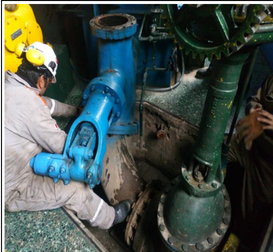
Fig. 71 Retiro de Inyector Inferior
