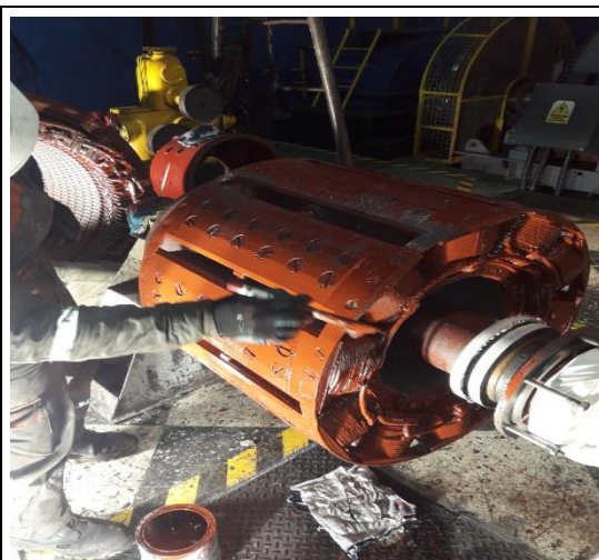
Fig. 116 Barnizado de Rotor del Generador Eléctrico
