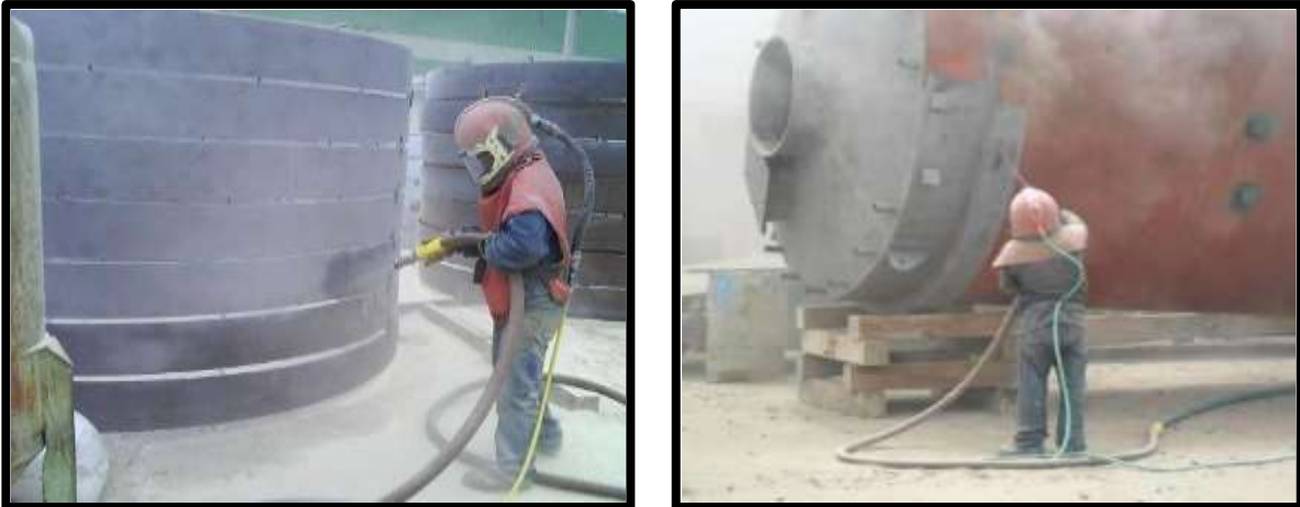
Figura N° 5 Preparación de superficie por chorro abrasivo seco de juntas (izquierda) y del exterior de un molino (derecha)
