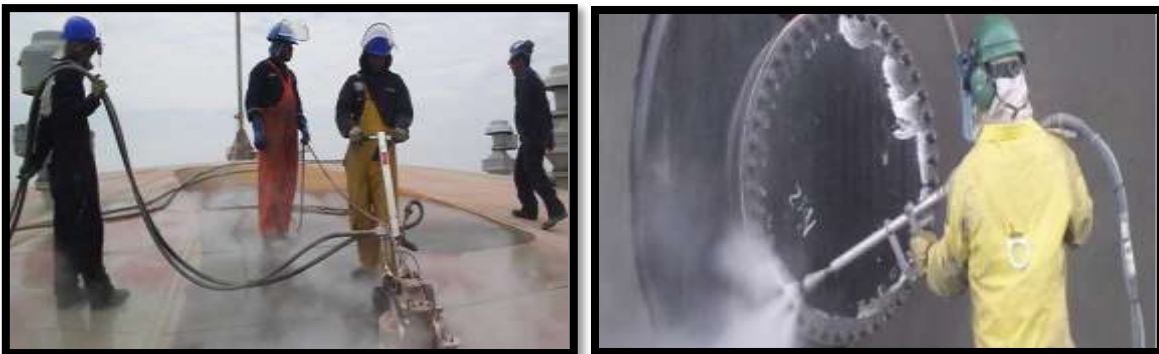
Figura N° 7 Las bridas de un tanque (izquierda) y la preparación de superficie por chorro de agua a ultra alta presión del techo (derecha)
