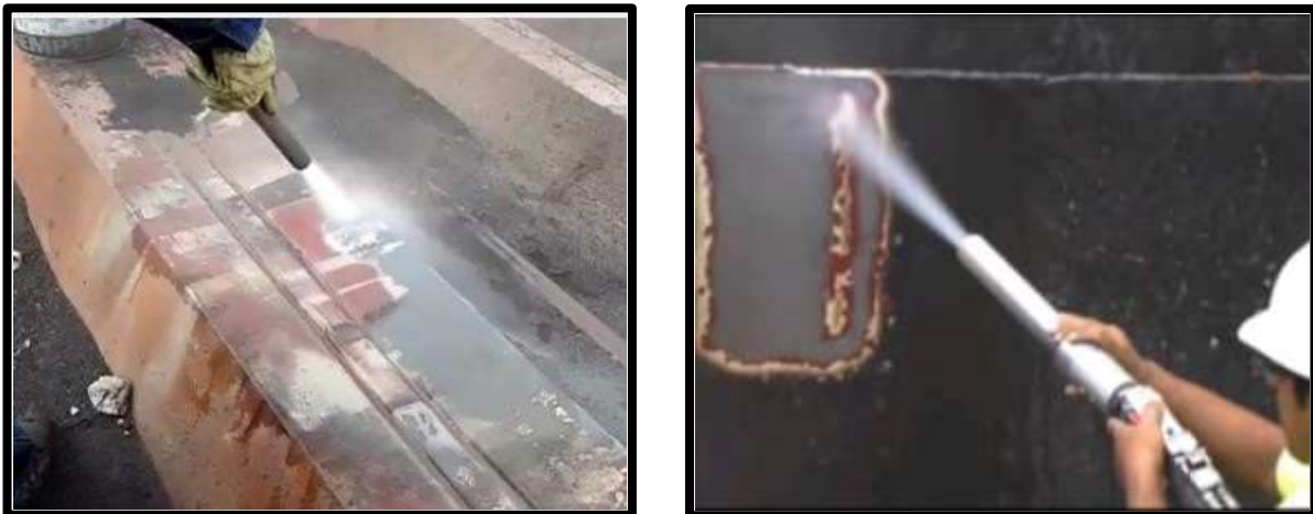
Figura N° 6 Preparación de superficie por chorro abrasivo húmedo
