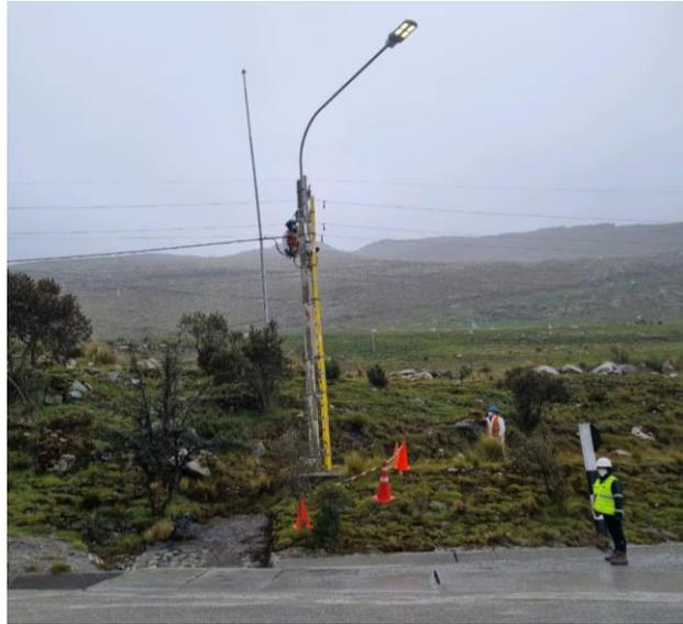
Fotografía N° 1: Mantenimiento y cambio de ferretería
