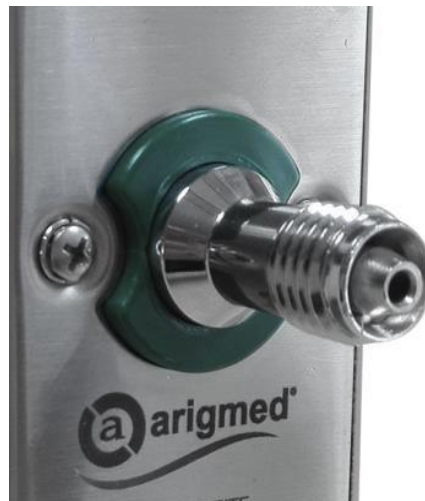
Figura N° 8. Conexión DISS de oxígeno.
