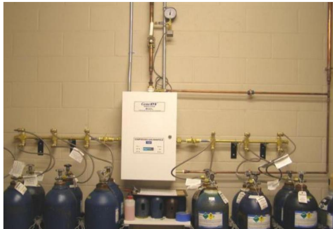
Figura N° 4. Imagen referencial de manifold de gas medicinal.
