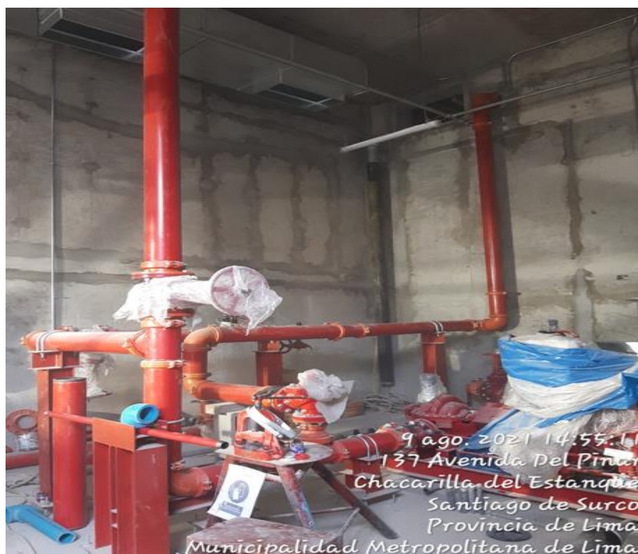
Figura 56 Montaje de tuberías en el cuarto de bombas
