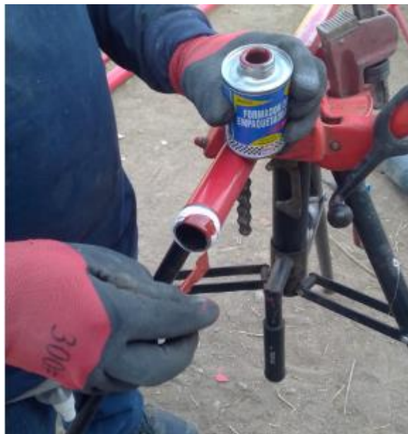
Figura 40 Se coloca formador de empaquetadura ADEX en la tubería
