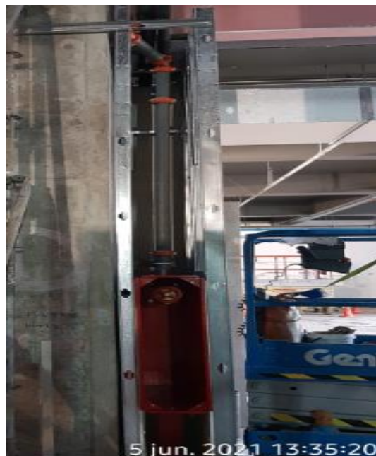
Figura 48 Montaje de gabinete de canto
