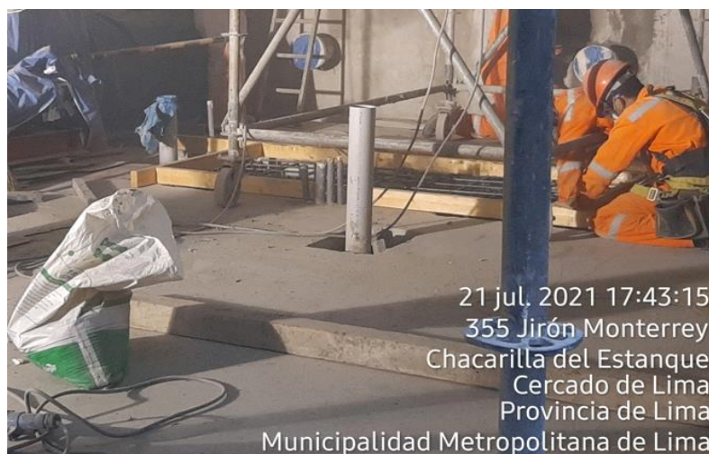
Figura 54 Encofrado de Podio de concreto
