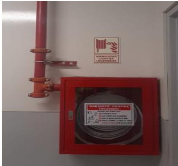
Figura 46 Montaje de gabinete adosado
