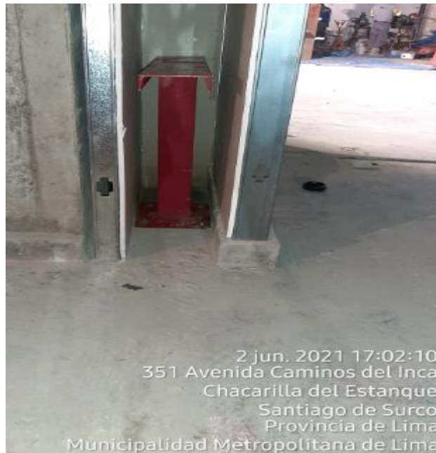
Figura 47 Montaje de soporte para gabinete de canto
