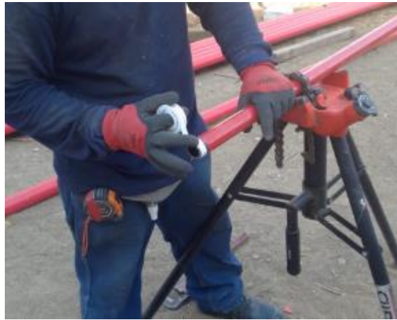
Figura 39 Tubería roscada, luego se coloca teflón
