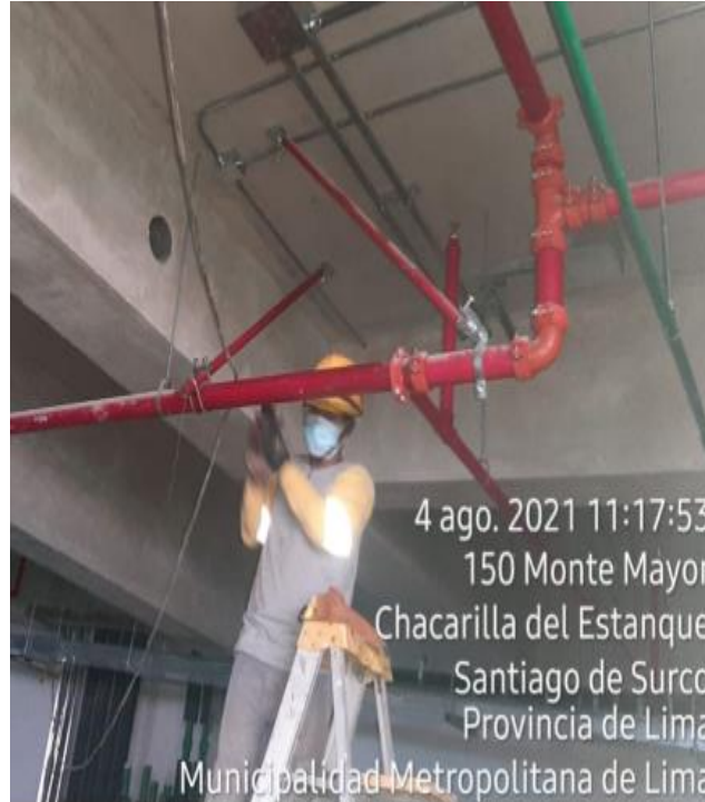
Figura 51 Soporte longitudinal – transversal (4 vías)
