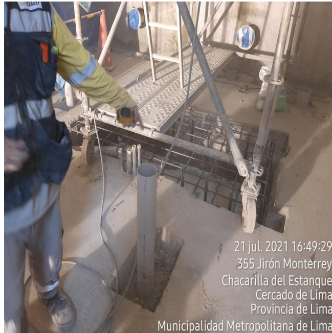
Figura 53 Enmallado del Podio de concreto
