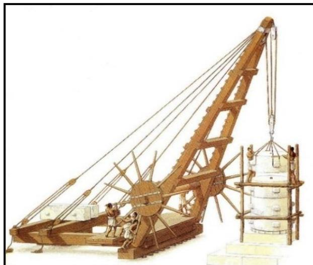
En ese siglo también se llegó a introducir el torno y la polea para reemplazar las rampas como medios principales de movimiento vertical, que eran utilizados para subir los bloques a las estructuras. Gracias al uso del torno y la polea, fue mucho más fácil la construcción de los templos griegos, pues esto permitió la carga de muchas piedras pequeñas por ser más práctico, que pocas piedras más grandes.
