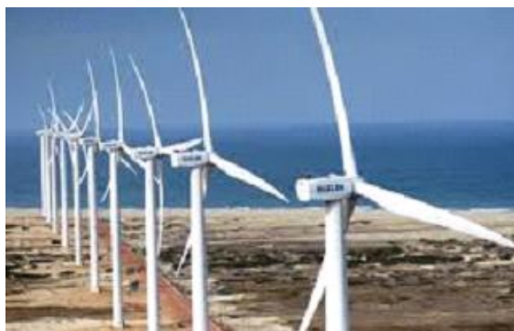
Figura 6. Parque eólico Nearshore.
