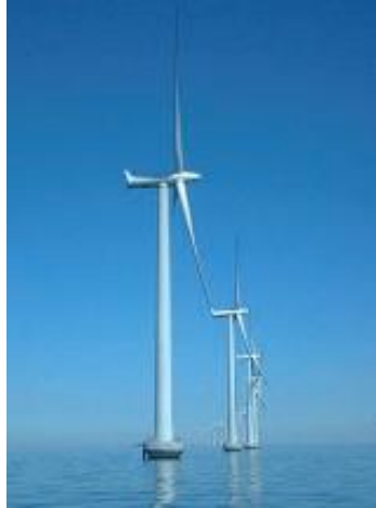
Figura 7. Parque eólico Offshore.
