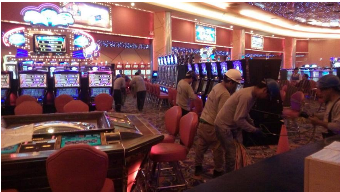
Figura 5. Trabajos de instalación de máquinas en la sala de juegos
