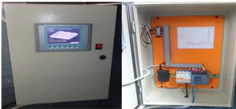
PLC instalado sobre perfil DIN de ½ pulgada, alimentación de 110 VAC, con breaker de 5 amperios de protección. KTP 600 con alimentación de 24 VDC única fuente, con breaker de 1 Amperio de protección.
