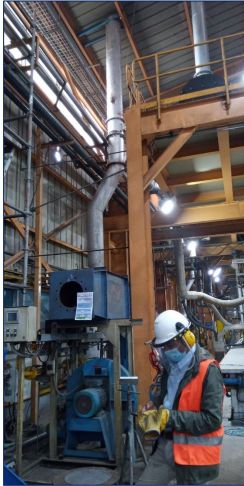
Figura 42. Plataforma de ubicación de la caldera.
