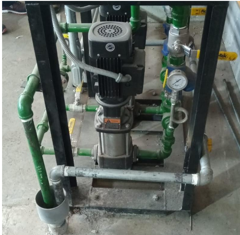
Figura N° 5 – Bomba multietapa vertical
