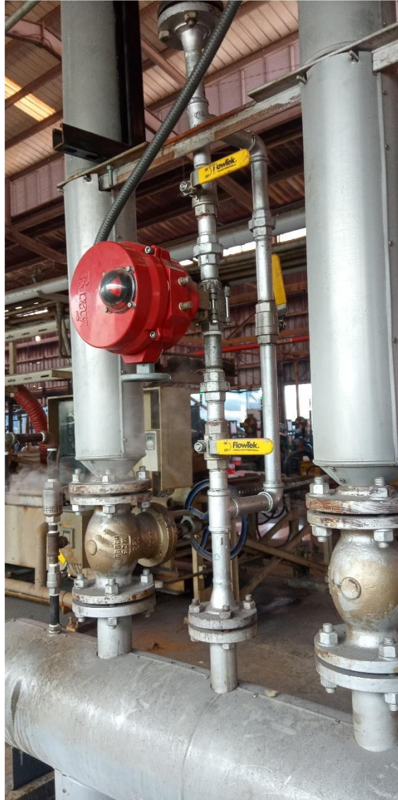
Figura N° 2 – Sistema de control de presión
