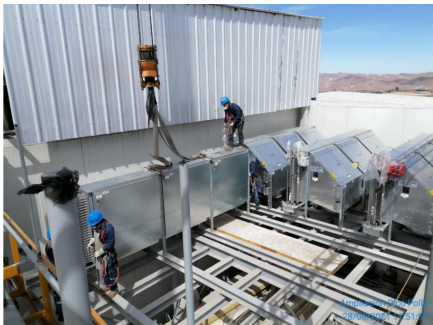
Figura III.29: Trabajos de izaje para posicional evaporadores de acuerdo con la distribución planteada en planos
