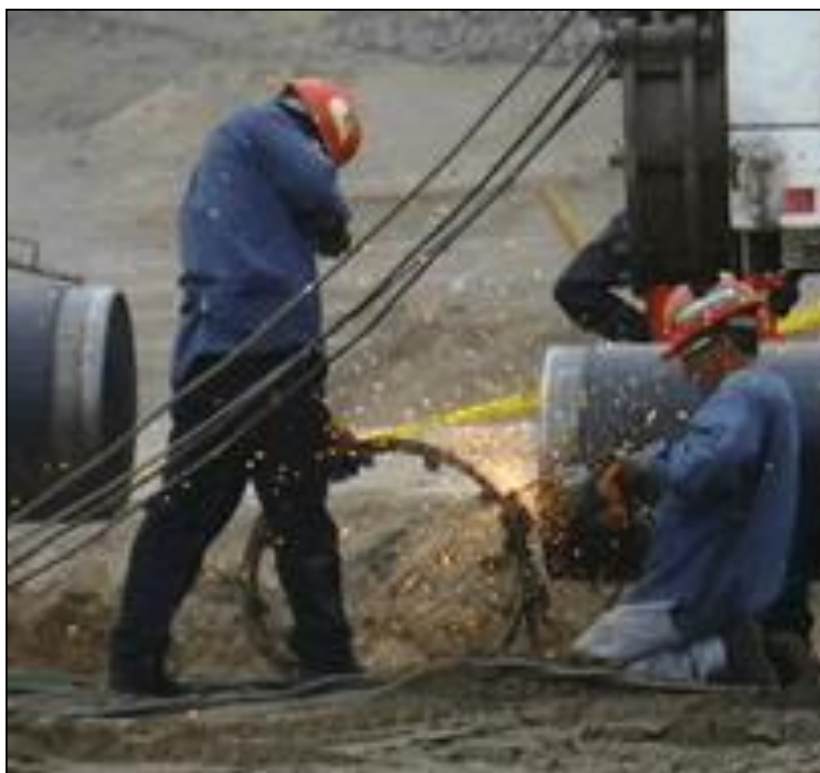
Figura II.5 Trabajos en red principal de Camisea
