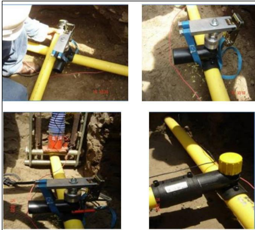
Figura II.21 Proceso de unión por electro fusión
