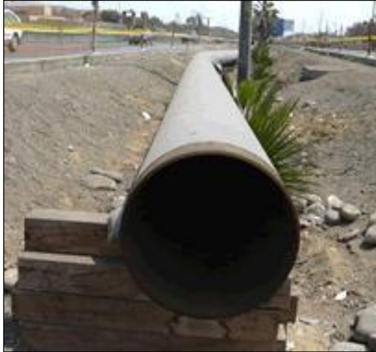
Figura II.6 Tendido de ducto de alta presión en Lima
