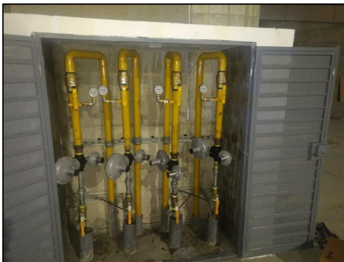
Figura II.36 Sistema de Regulación con DIVAL 500
