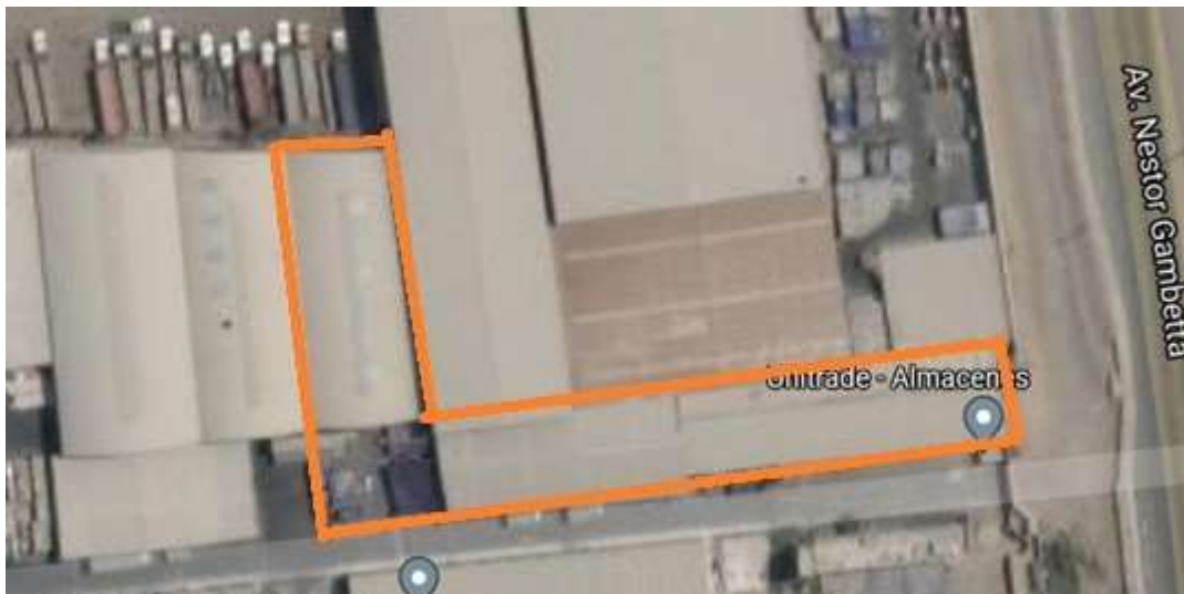
Figura N° 3.1 Vista panorámica del área de plásticos
