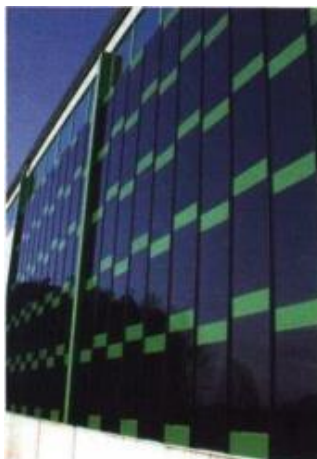
Figura 10. Ejemplo de módulos fotovoltaicos integrados en la fachada (Schott Solar). Tomado del libro Instalaciones solares fotovoltaicas ( Castejón, y otros, 2010 ).
