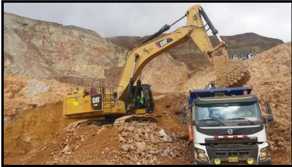
Figura 5 CARGIO CON EXCAVADORA AL VOLQUETE
