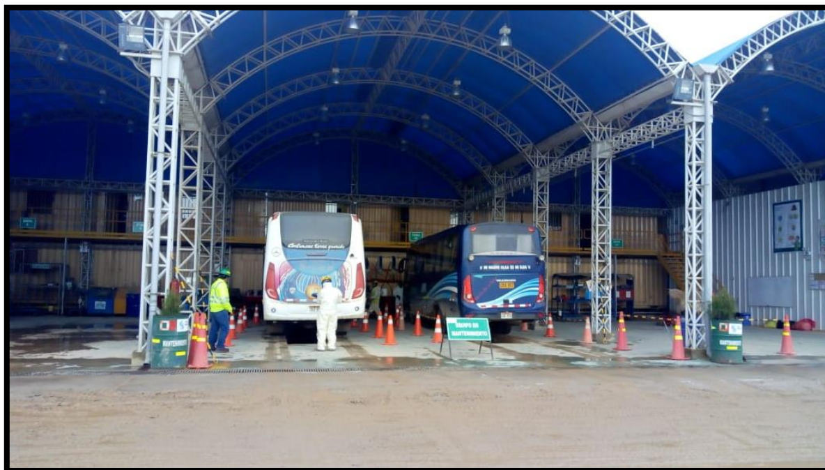
Figura 6 TALLER DE MANTENIMIENTO PREVENTIVO Y CORRECTIVO
