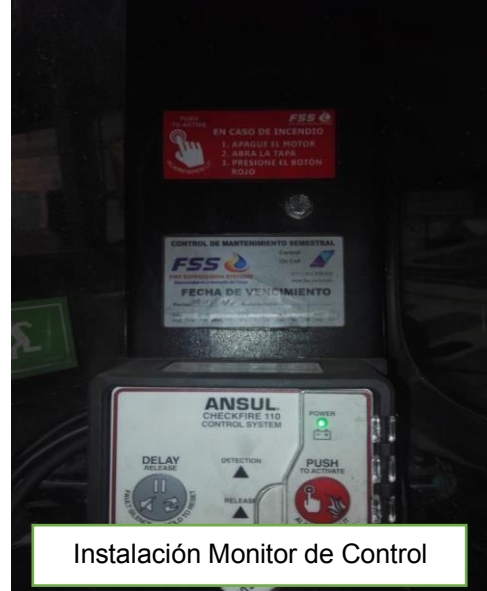
Figura 3.25: Instalación de tanques y monitor de control
