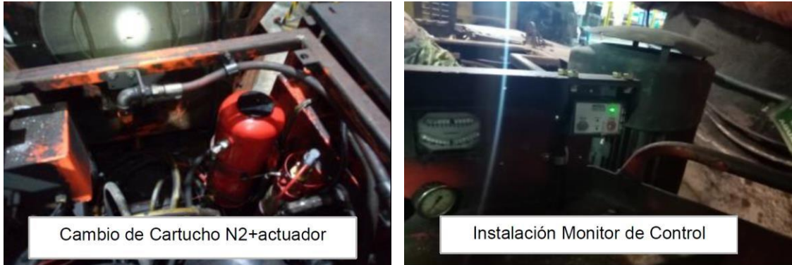
Figura 3.19: Instalación de tanque y monitor de control
