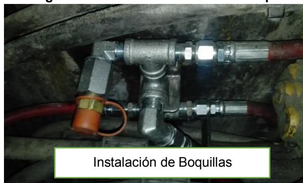
Figura 3.27: Instalación de boquillas
