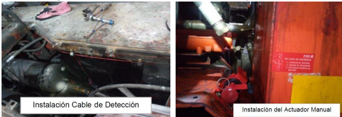
Figura 3.20: Instalación del cable de detección y actuador manual
