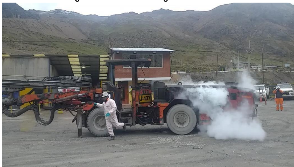
Figura 3.38: Descarga del sistema ANSUL
