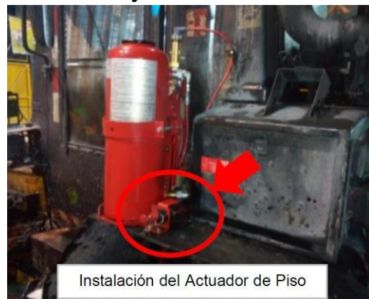
Figura 3.17: Instalación del cable de detección y actuador manual
