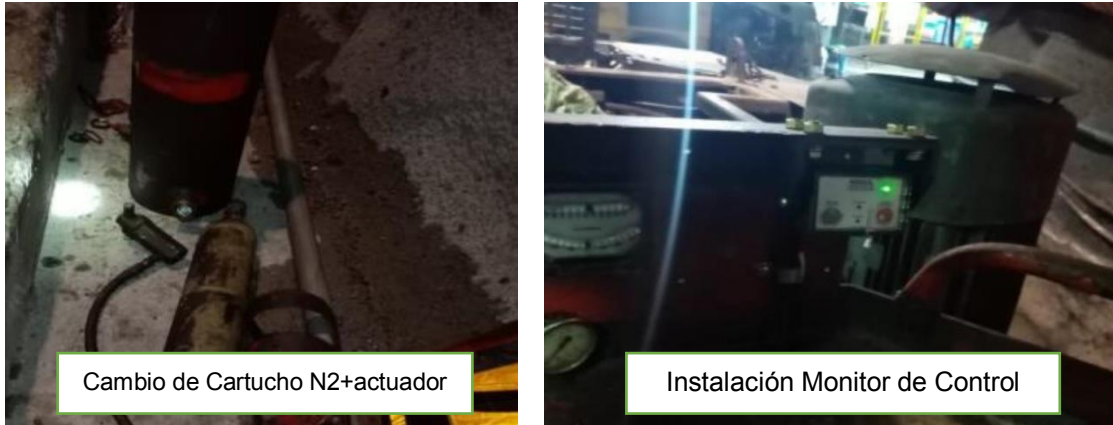
Figura 3.22: Cambio de Cartucho de nitrógeno e instalación monitor control
