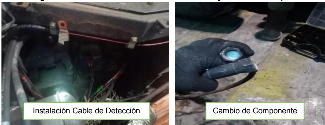
Figura 3.23: Instalación cable de detección y cambio de componentes
