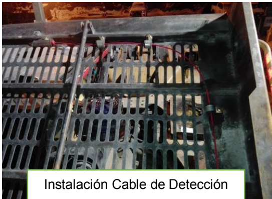
Figura 3.26: Instalación cable de detección y actuador de piso
