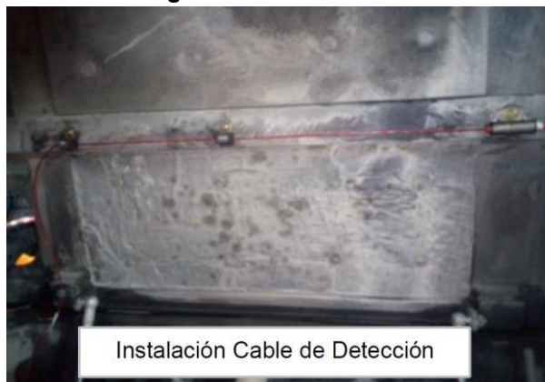
Figura 3.17: Instalación del cable de detección y actuador manual
