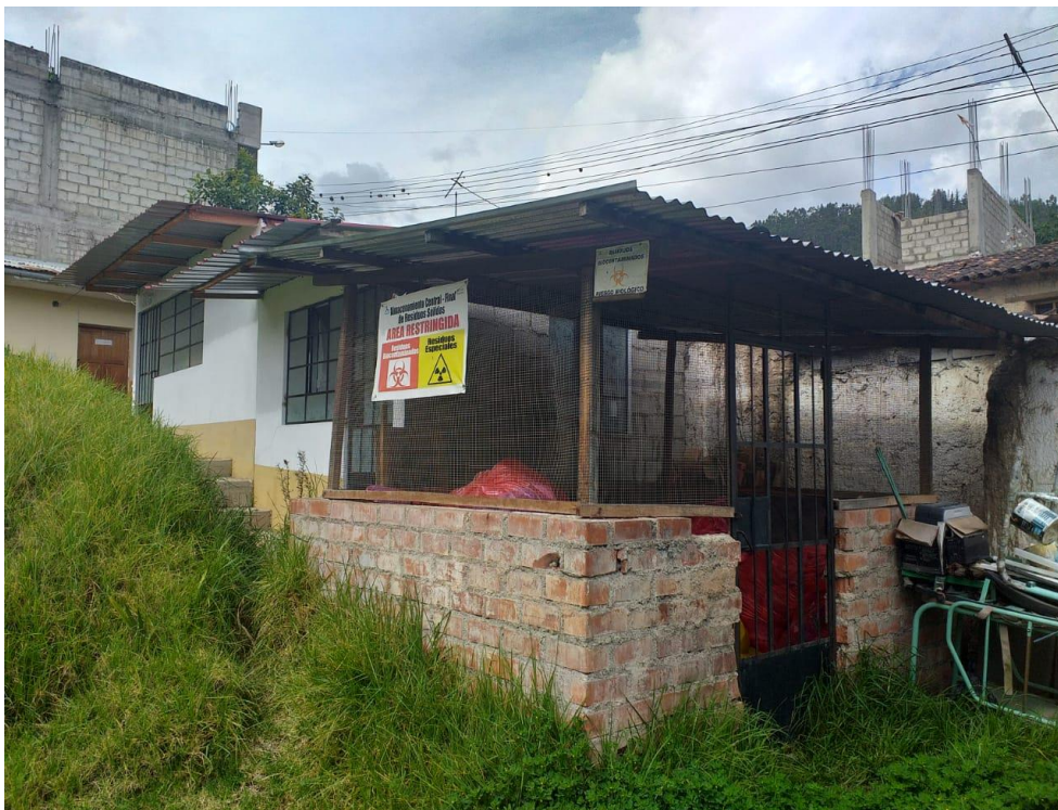
Figura N°34. Señalización y adecuación de almacén central.
