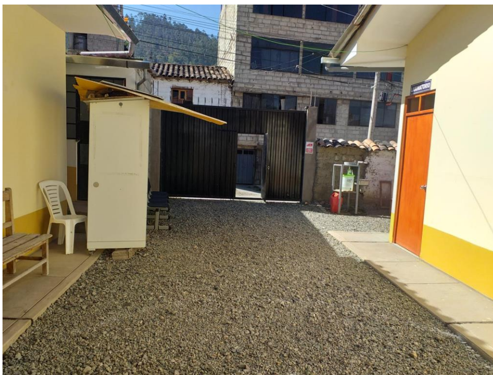
Figura N°20. Estado actual pasadizos de área COVID-19.
