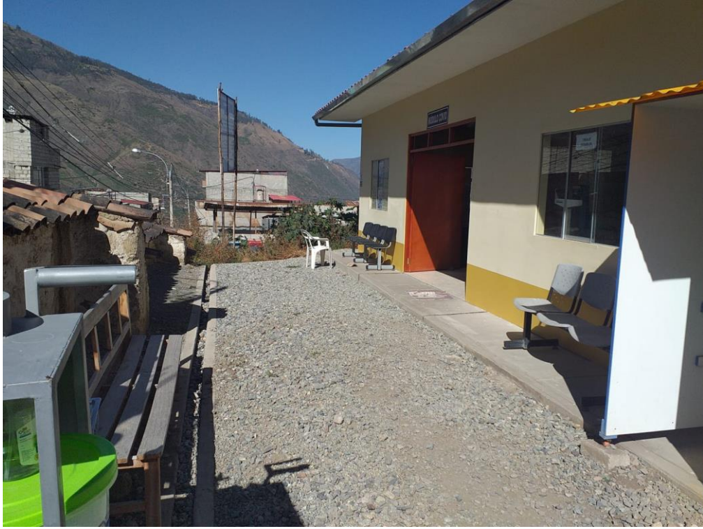
Figura N°21. Estado actual pasadizos de área medicina COVID-19.
