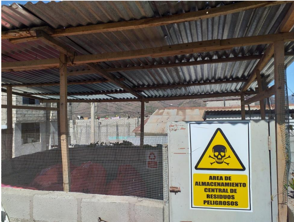
Figura N°35. Señalización y adecuación de almacén central de manejo de residuos sólidos.
