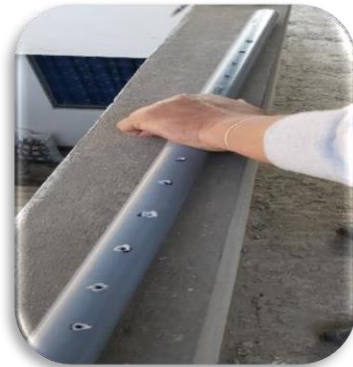
Perforación de tuberías de PVC para la caída por gravedad del agua residual
