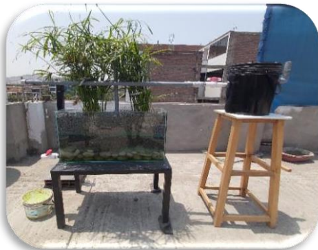
Trampa de grasa seguido del biofiltro
