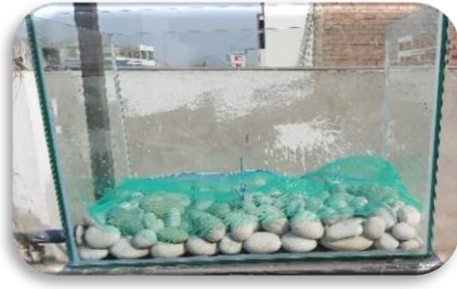
Colocación de piedra de canto rodado en ambos biofiltros
