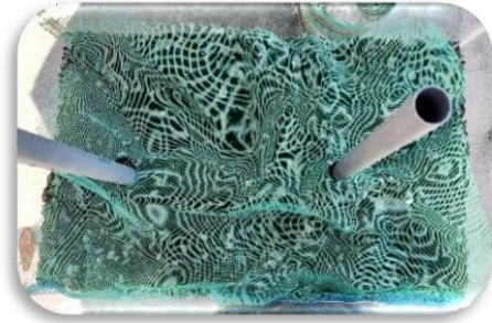
Colocación de tuberías de aireación
