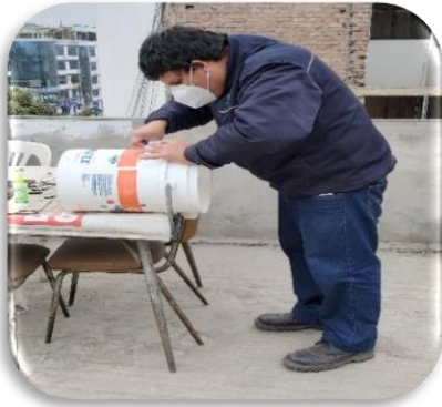
Perforación de trampas de grasa para el paso del agua residual
