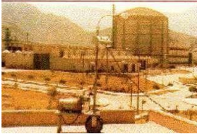
Figura N° 10 – Vista desde el edificio de seguridad radiológica
