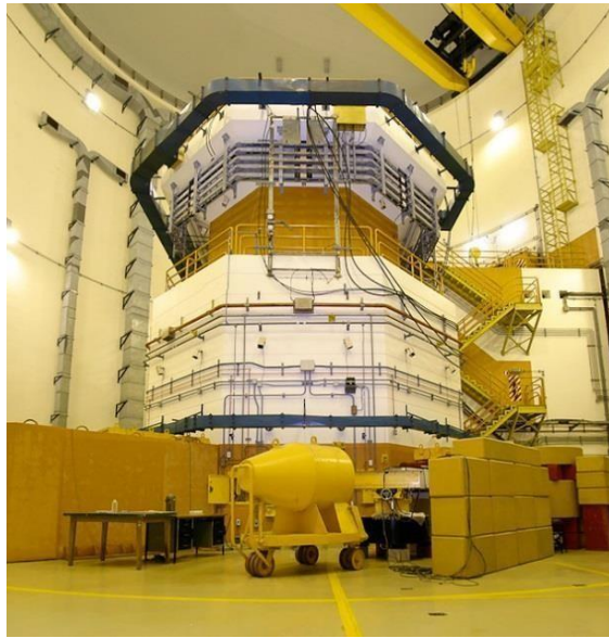
Figura N° 3 – Bloque del Reactor RP – 10
