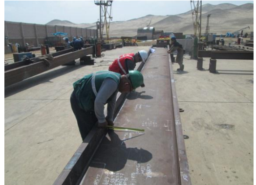
Trabajos de soldadura en estructuras principales
