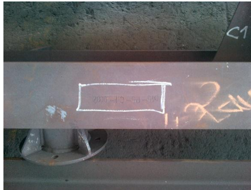
Marcado de estructuras
