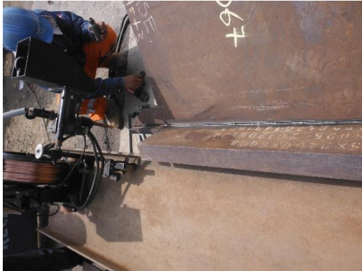
Trabajos de soldadura en estructuras principales
