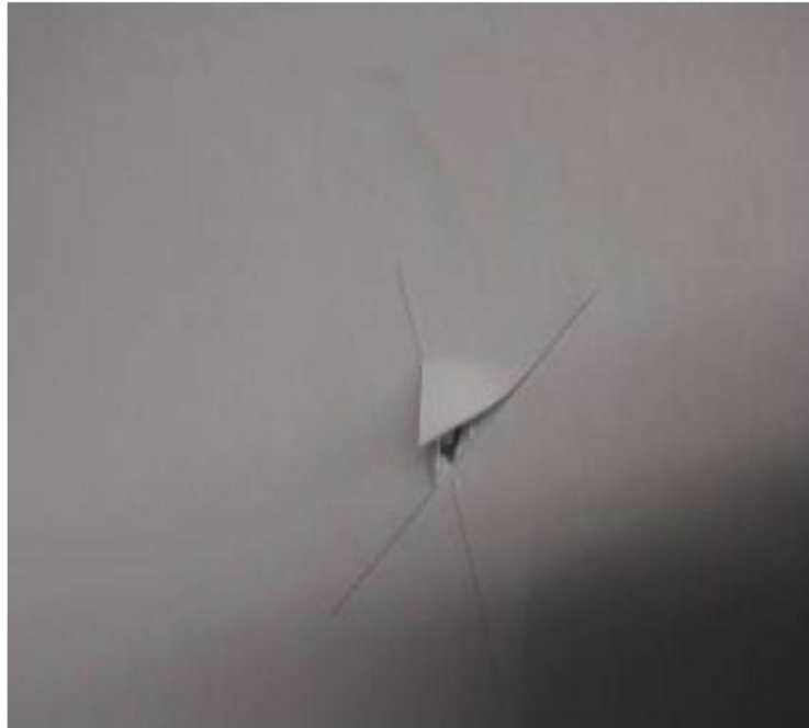
PRUEBA DE CORTE EN PLANCHAS NO CONFORME
