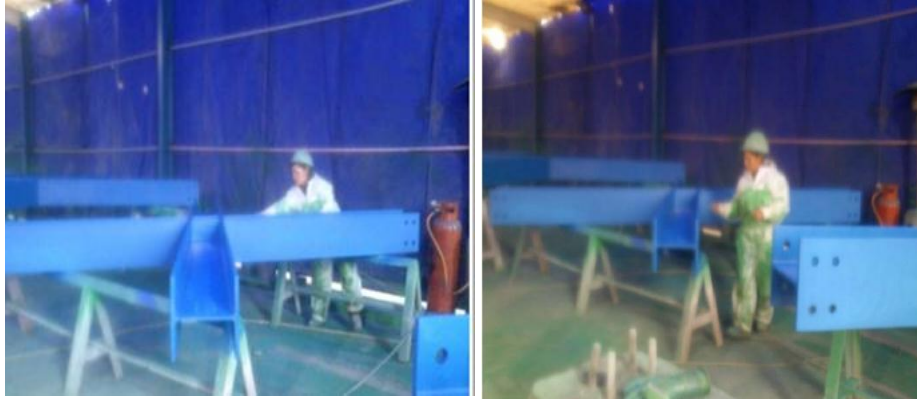
Aplicación de protección superficial
