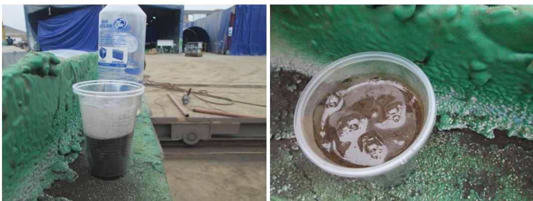
Control de condiciones granalla para inicio de tratamiento superficial
