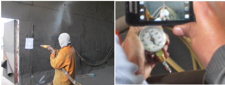
Control de condiciones de equipos para inicio de tratamiento superficial
