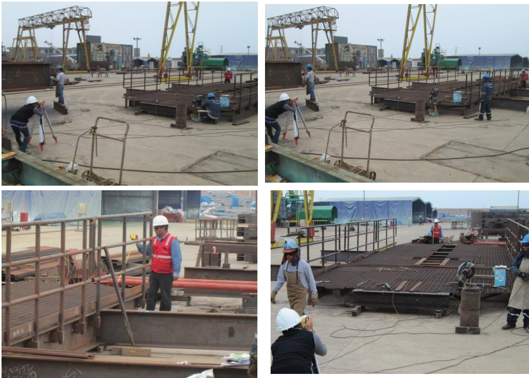
Nivelación de plataforma principal
