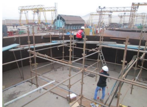
Nivelación de base cono principal de descarga
