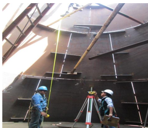
Nivelación de cono principal de descarga
