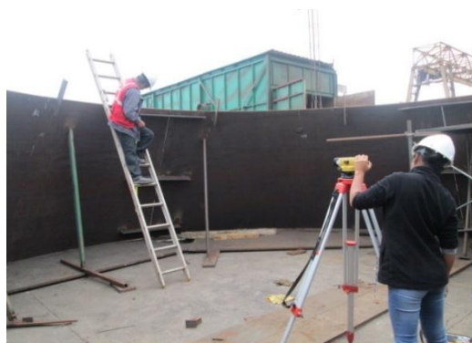
Nivelación de base cono principal de descarga
