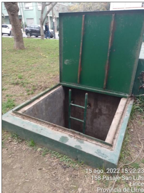
Reservorio de agua del parque Ramón Castilla
