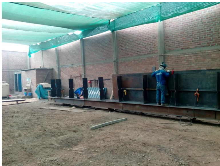
Figura 44 Soldadura de refuerzo de viga puente grúa
