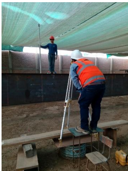
Figura 49 Alineamiento y nivelación de viga de puente grúa
