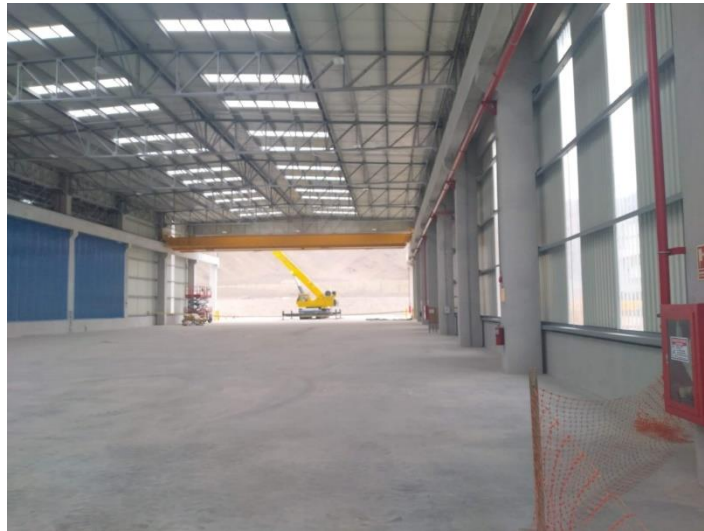
Figura 78 Izaje de puente grúa
