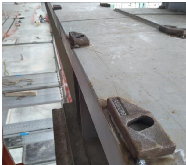
Figura 62 Clips de fijación apuntalados
