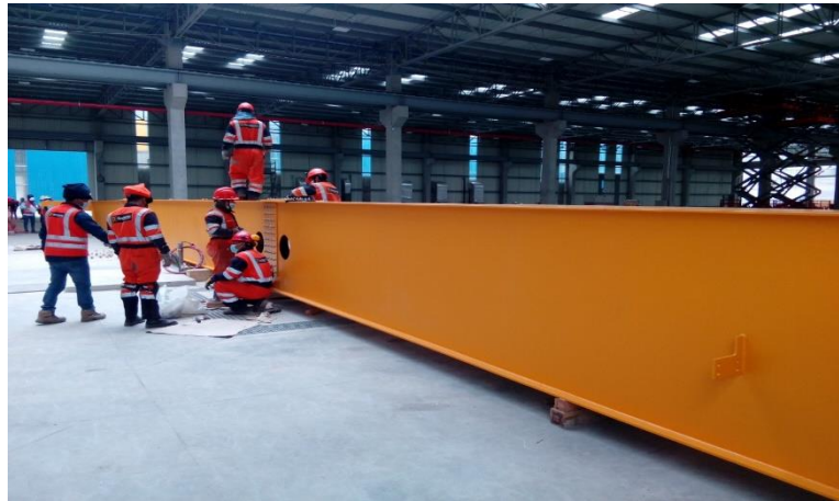
Figura 72 Ensamble estructural de vigas tipo cajón
