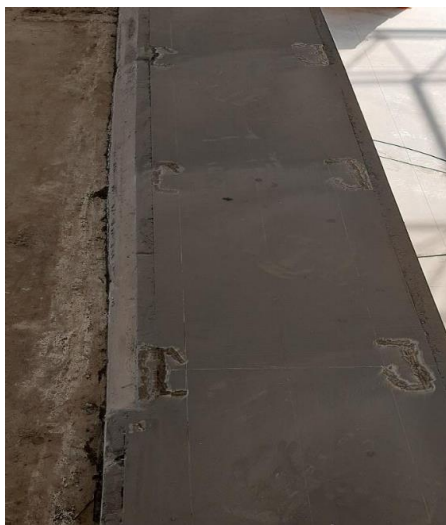
Figura 60 Trazado de punto dónde serán instalados los clips
