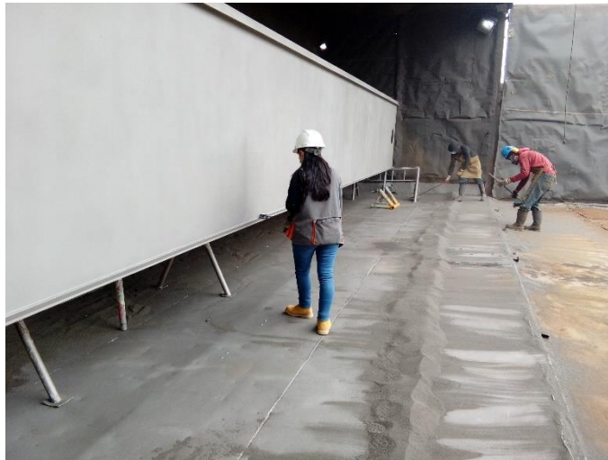
Figura 53 Control de limpieza superficial de viga puente grúa
