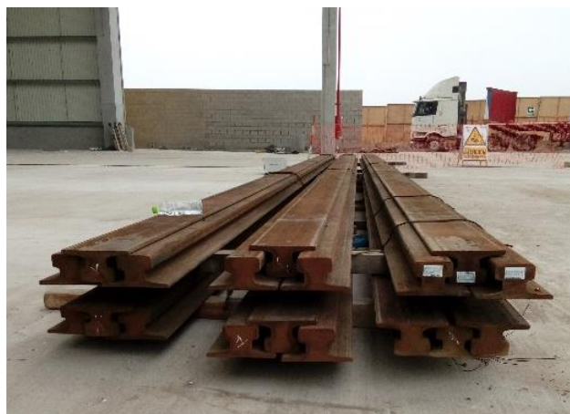
Figura 31 Descarga de rieles de rodadura A75
