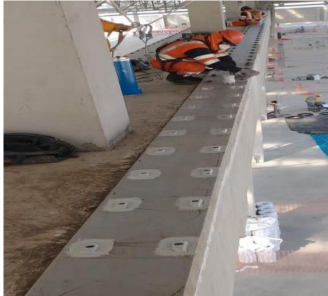
Figura 65 Recubrimiento superficial de clips de fijación
