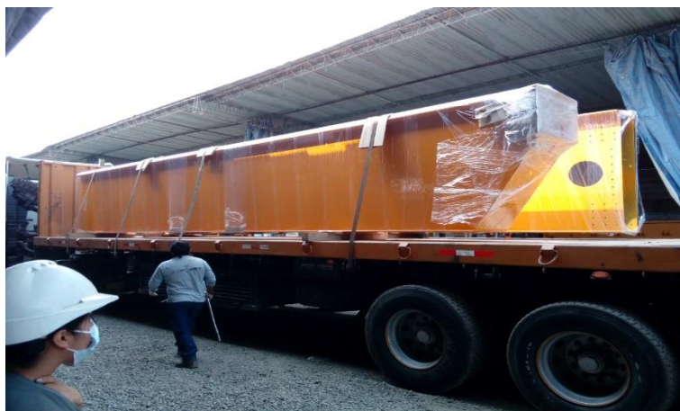
Figura 71 Traslado de puente grúa
