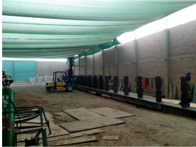
Figura 39 Armado de refuerzos interiores PG15T_VIC_11
