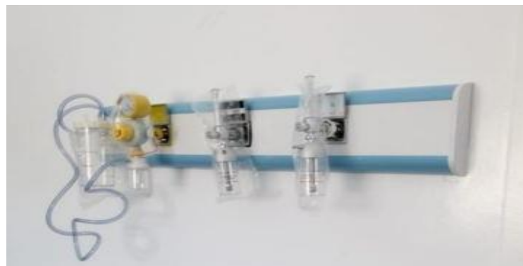
Figura 2.7 Punto de suministro de vacío médico en un panel de cabecera (Made In, 2019).
