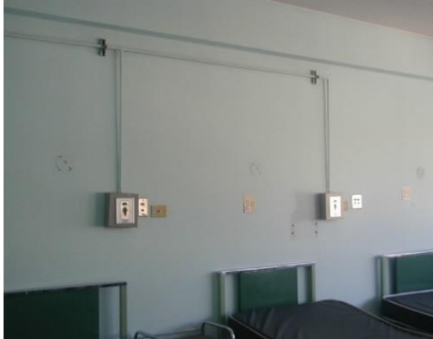
Figura 3.19 Instalación de salidas tipo Diss sobre puertas (LINDE GAS THERAPEUTICS, 2008).
