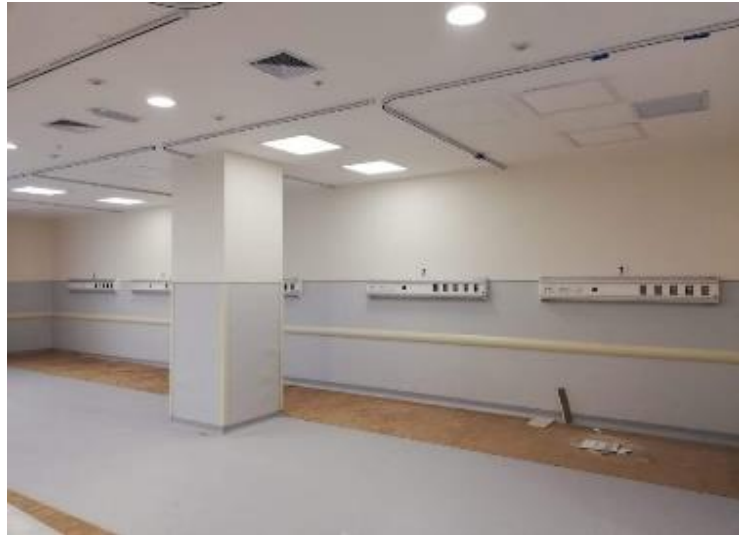
Figura 1.12 Equipamiento biomédico instalación de paneles de cabecera en el Hospital INEN (ONERGY, 2022).
