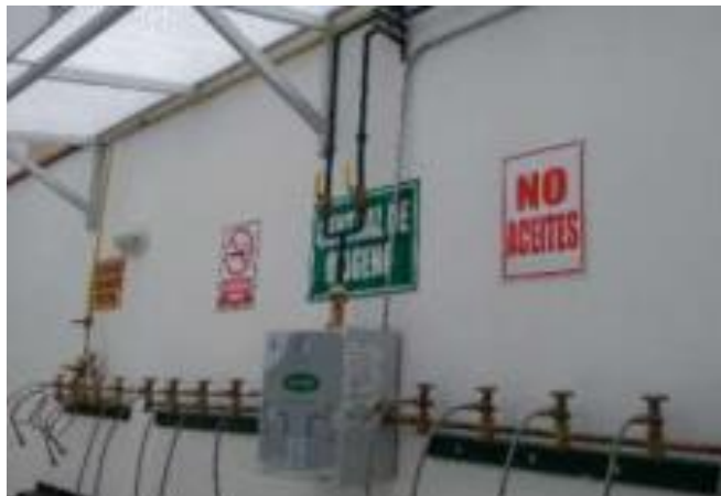
Figura 1.2 Instalación de manifold de emergencia de oxígeno medicinal (ONERGY, 2022).
