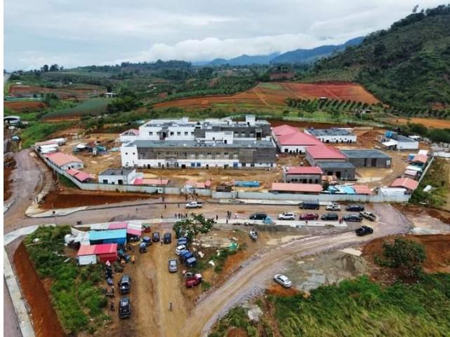
Figura 1.4. Vista panorámica del estado actual del Hospital de nivel II – Pangoa (ONERGY, 2022).
