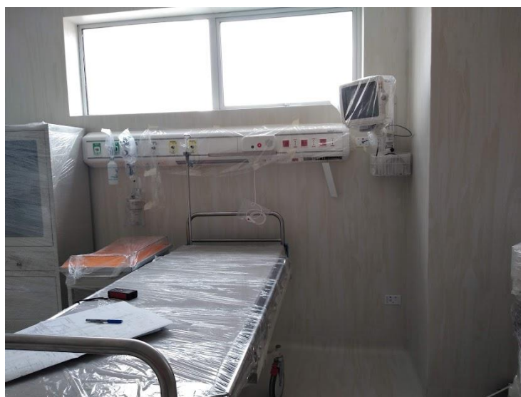
Figura 3.20 Instalación de panel de cabecera (ONERGY, 2022).
