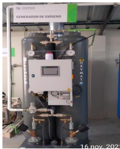
Figura 1.5 Planta generadora de oxígeno en la Universidad Señor de Sipán – Chiclayo (ONERGY, 2022).
