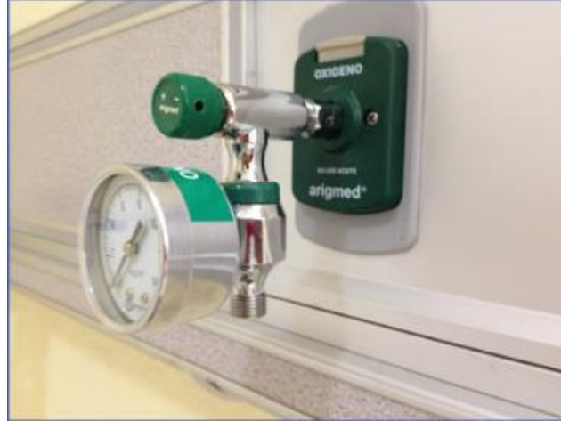
Figura 3.21 Salida de oxígeno medicinal en panel de cabecera (OXITOLIMA, 2022).
