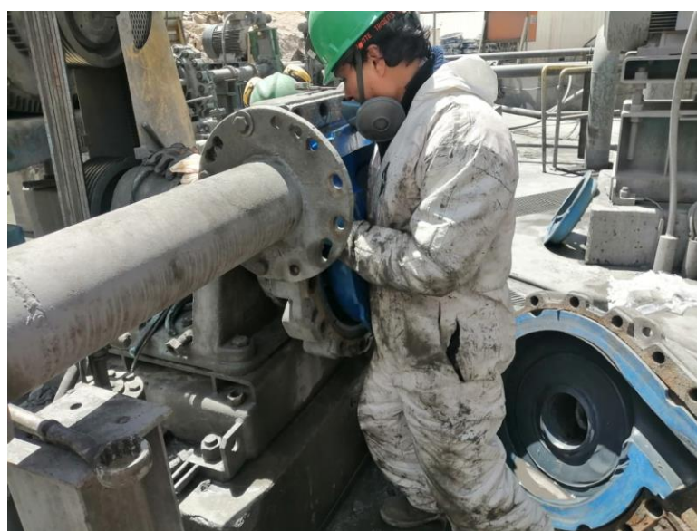
Figura 4.15 Inspección de bomba a las 300 Horas de funcionamiento
