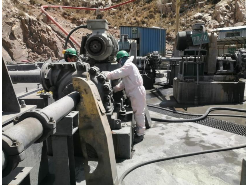
Figura 4.20 Inspección de cilindro portarodamiento y sistema transmisión por poleas
