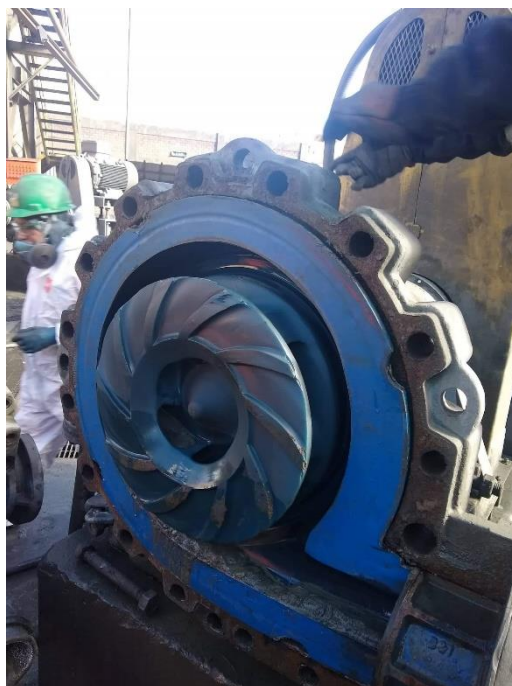
Figura 4.14 Inspección de bomba a las 300 Horas de funcionamiento
