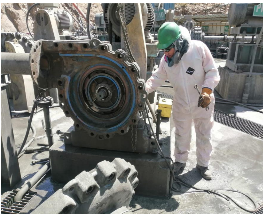
Figura 4.17 Elementos húmedos desgastados
