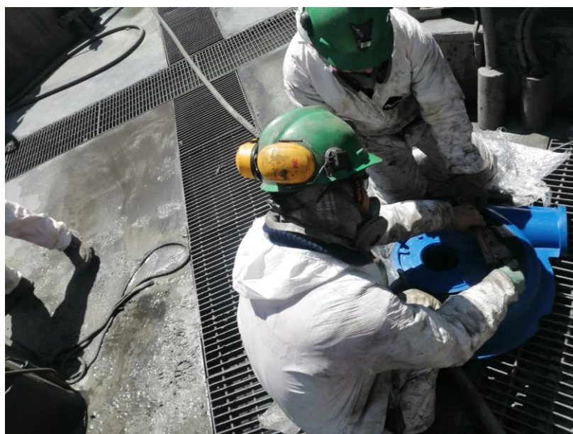
Figura 4.19 Instalación de espárragos para cambio de forros
