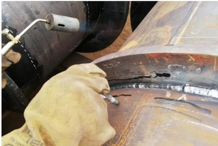
*Figura 27: Tiza térmica derretida al aplicarla sobre el metal base pre calentado*
