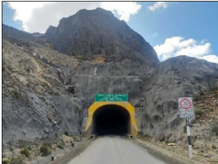
Figura N° 2.10 Efecto agujero negro en túnel punta olímpica
