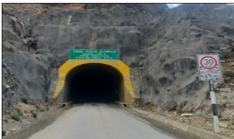
Figura N° 4.6 Velocidad máxima permitida en el túnel punta olímpica
