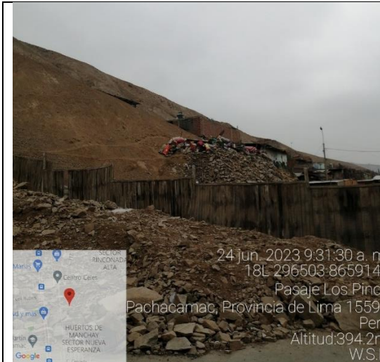
Presencia de residuos en áreas aledañas
