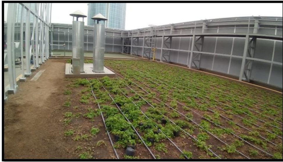
Figura 17. Techo Técnico Edificio Torre del Parque.
