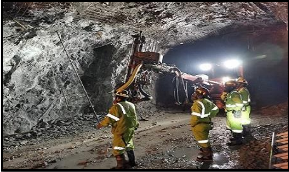
Figura 1 Servicio de Excavaciones subterráneas
