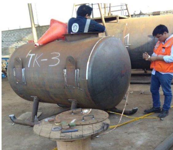
Inspección del interior y exterior del Tanque
