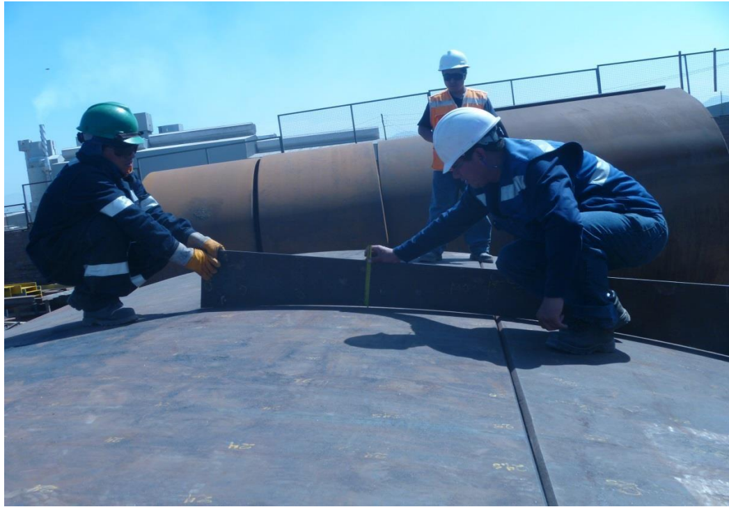
FOTO N° 5.5. PROCESO DE VERIFICACION DE CURVATURA EN MODULO. Fuente: Propia
