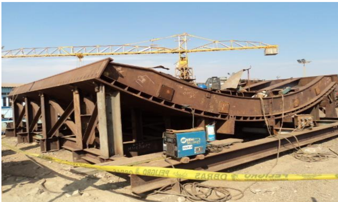
FOTO N° 5. 2. CUERPO DE COMPUERTA ARMADA SOBRE CAMA Fuente: Propia
