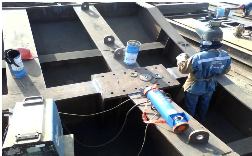
FOTO N° 5.3. PREPARACION PARA SOLDADURA DE COMPUERTA RADIAL. Fuente: Propia.
