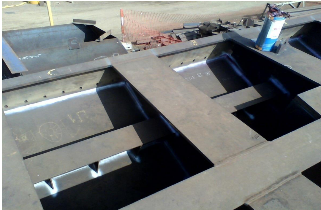
FOTO N° 5.4. ENSAYO NO DESTRUCTIVO DE TINTES PENETRANTES EN HOJA Y REFUERZOS RADIALES DEL CUERPO DE COMPUERTA. Fuente: Propia.
