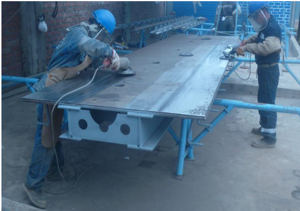
FOTO N° 5.27 PULIDO DE BLINDAJE SOLERA MECANIZADA Fuente: Propia.
