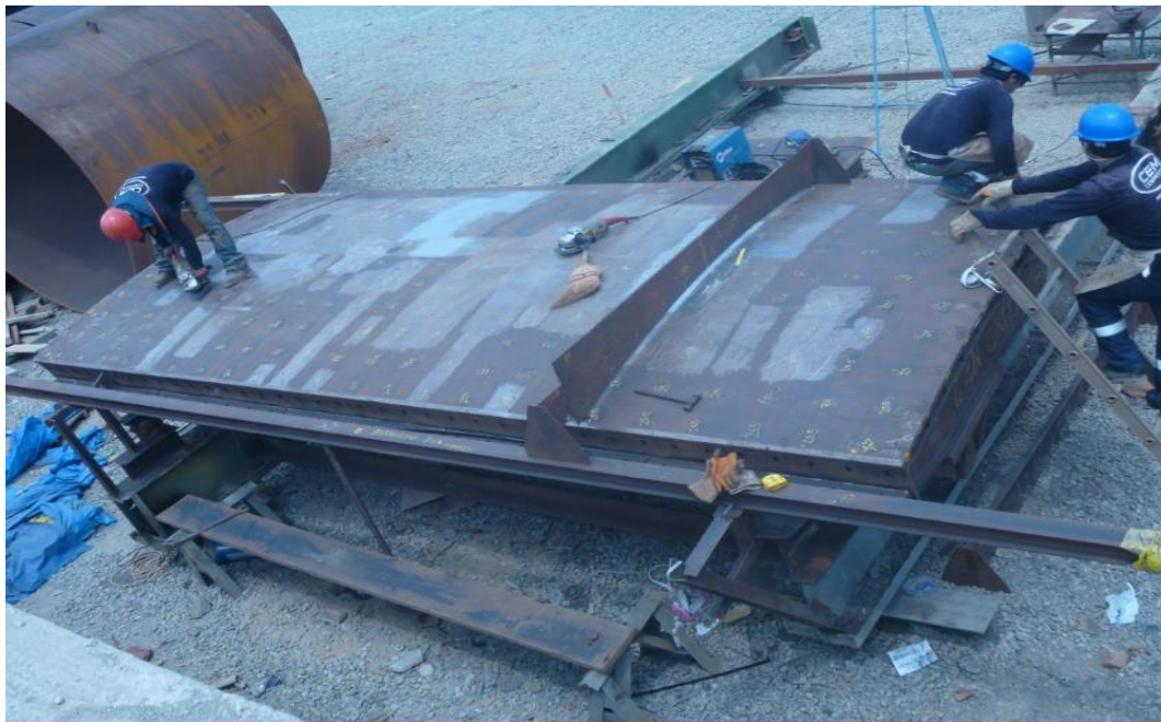
FOTO N° 5.6. ESMERILADO Y CONTROL DE CURVATURA EN MODULO. Fuente: propia.
