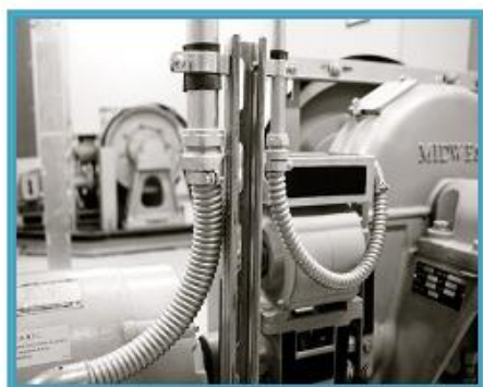
Reparación de Ascensores
