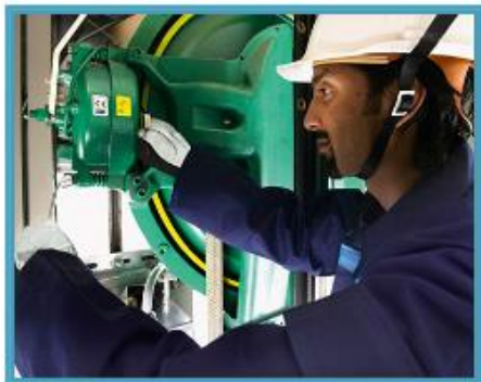
Instalación de Ascensores
