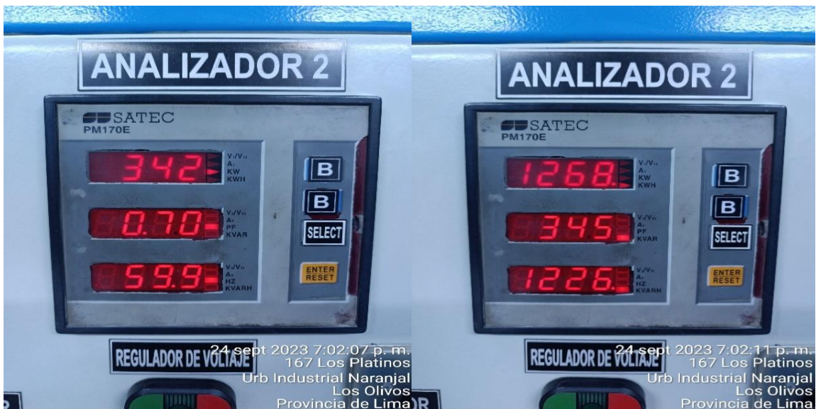
Figura N°163 Perdidas a corriente nominal y Perdidas reactivas a corriente nominal, Fase 2 de la prueba, 15 kVA
