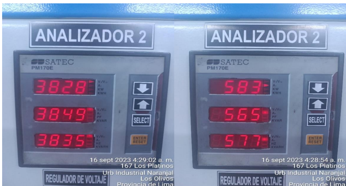
Figura N°78 Tensiones a corriente nominal y Corrientes nominales, Fase 2 de la prueba, 100 kVA
