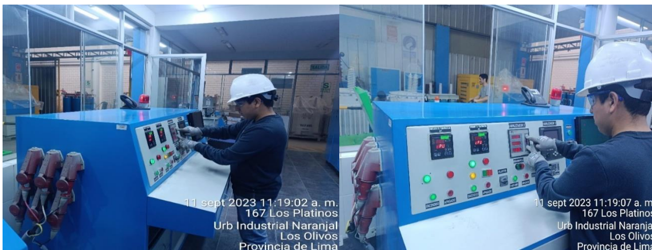
Figura N°49 Encendido del módulo eléctrico y Regulación de pérdidas totales
