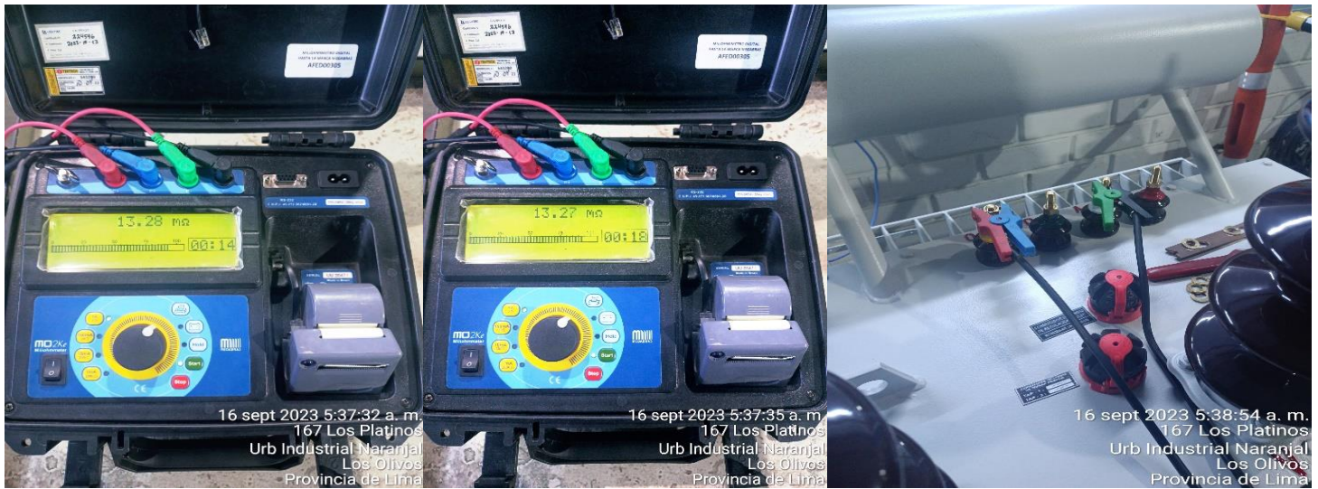
Figura N°80 Medición de resistencias en caliente, lado de baja tensión, 100 kVA
