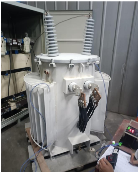
Figura N°25 Colocación de sensores de temperatura PT-100 Fuente: Elaboración propia
