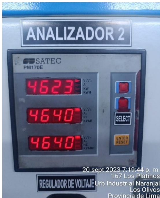
Figura N°123 Tensiones de pérdidas totales, 160 kVA
