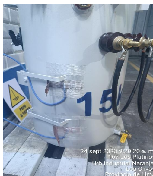
Figura N°145 Colocación de placa metálica de cobre, 15 kVA Fuente: Elaboración propia
