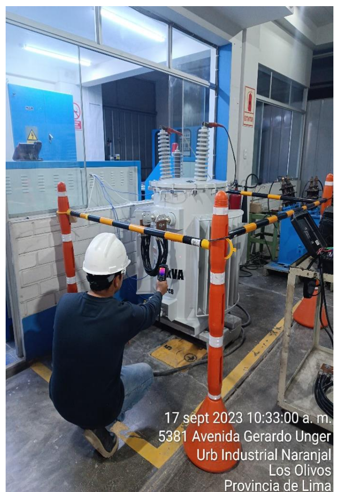
Figura N°56 Medición de temperatura media
