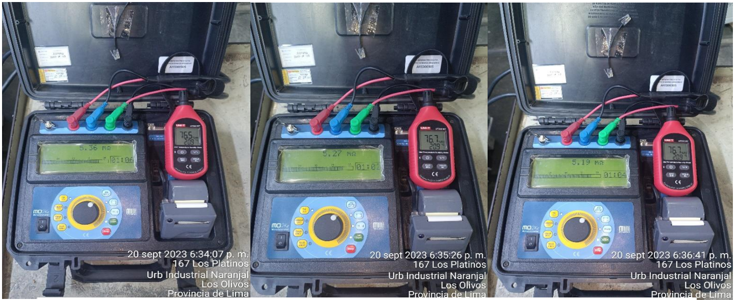
Figura N°118 Medidas de resistencias de arrollamientos, lado de baja tensión, 160 kVA Fuente: Elaboración propia
