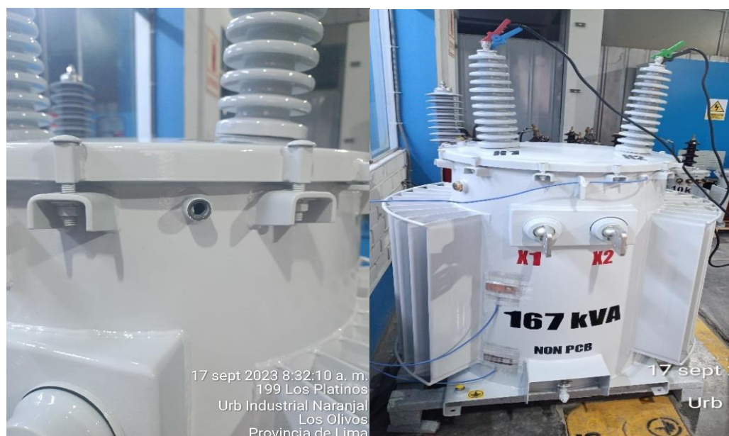
Figura N°90 Colocación de sensor de temperatura por válvula de alivio del transformador, 167 kVA
