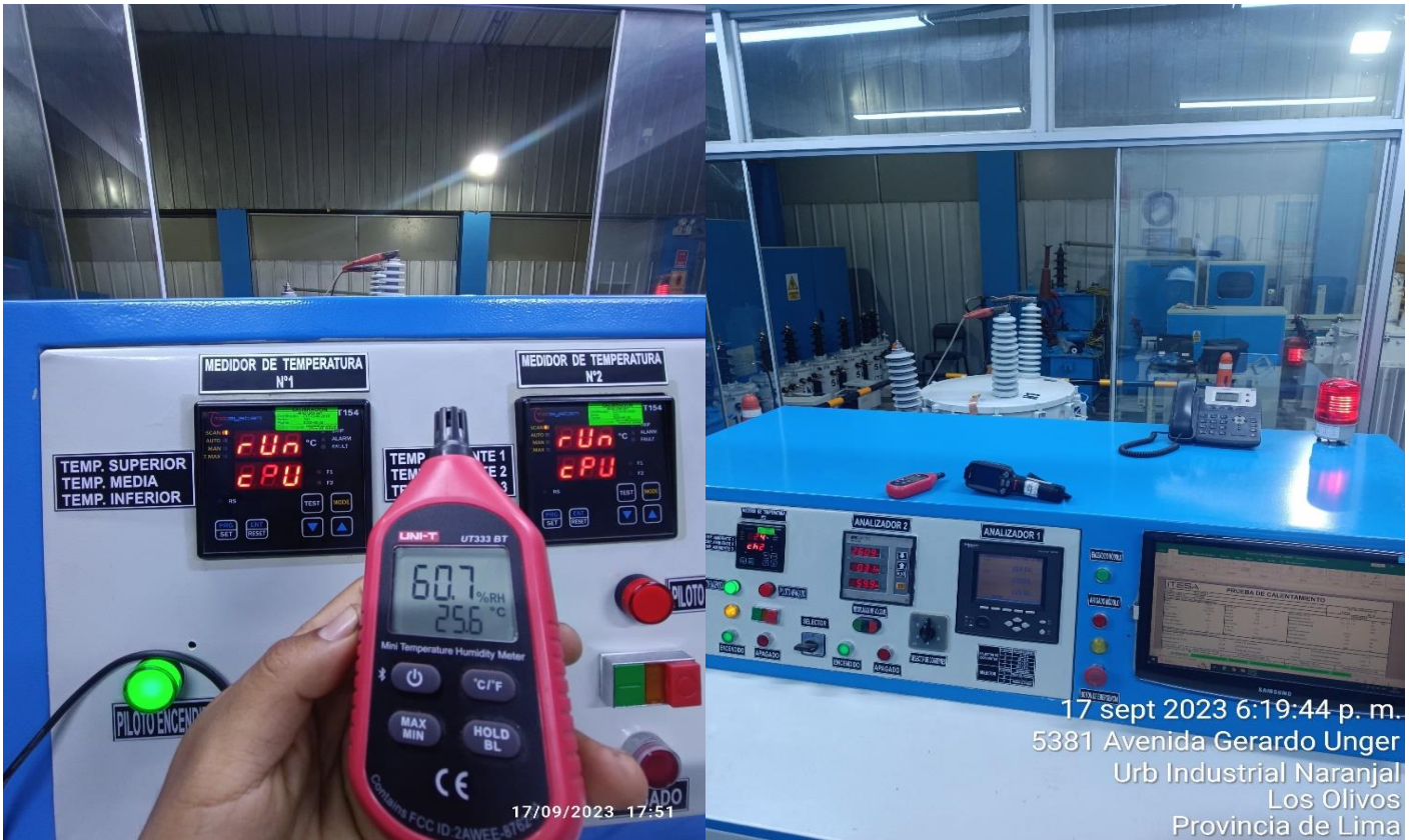
Figura N°103 Temperatura ambiente N°4 y humedad, 167 kVA
