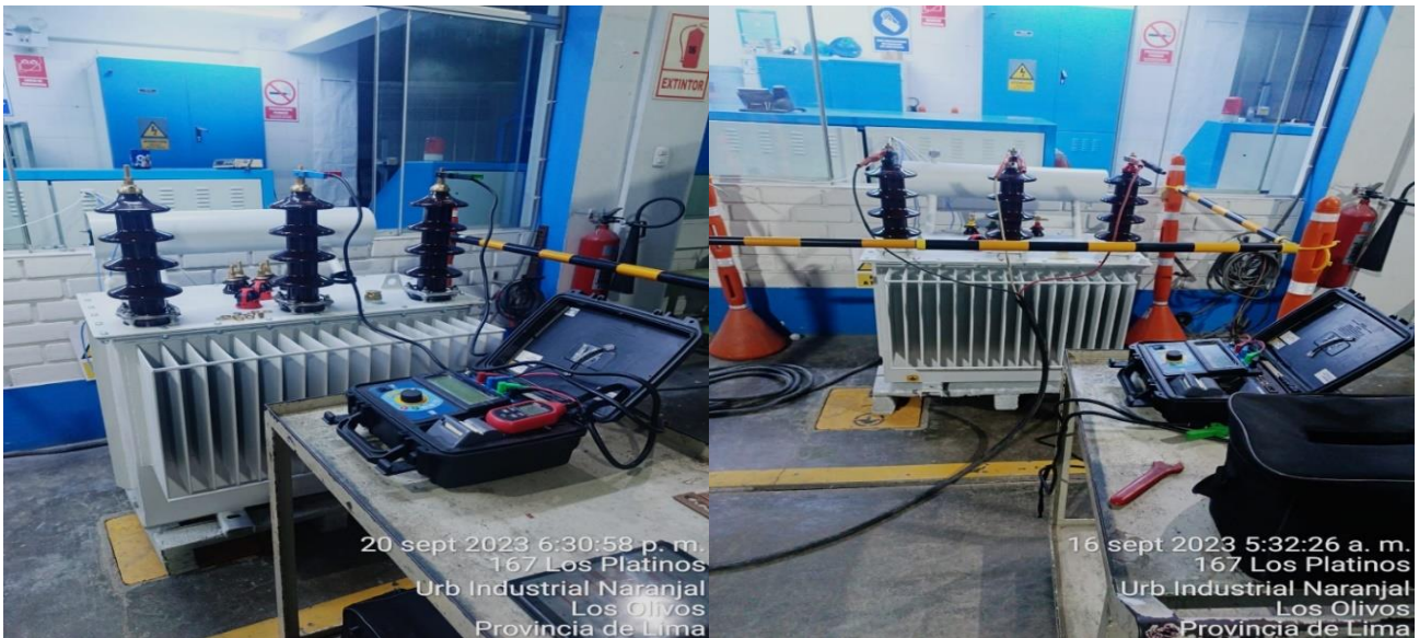
Figura N°52 Medición de arrollamientos antes de la prueba y Colocación de cables de prueba
