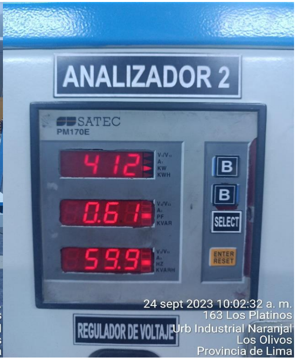
Figura N°151 Módulo eléctrico en funcionamiento y Pérdidas totales y factor de potencia, 15 kVA
