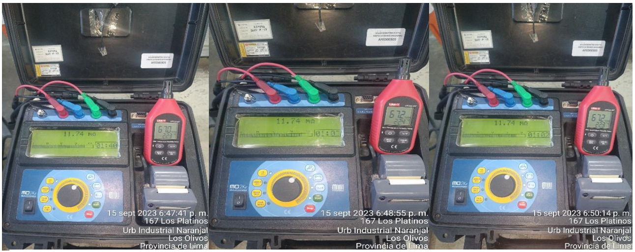
Figura N°66 Medidas de resistencias de arrollamientos, lado de baja tensión, 100 kVA
