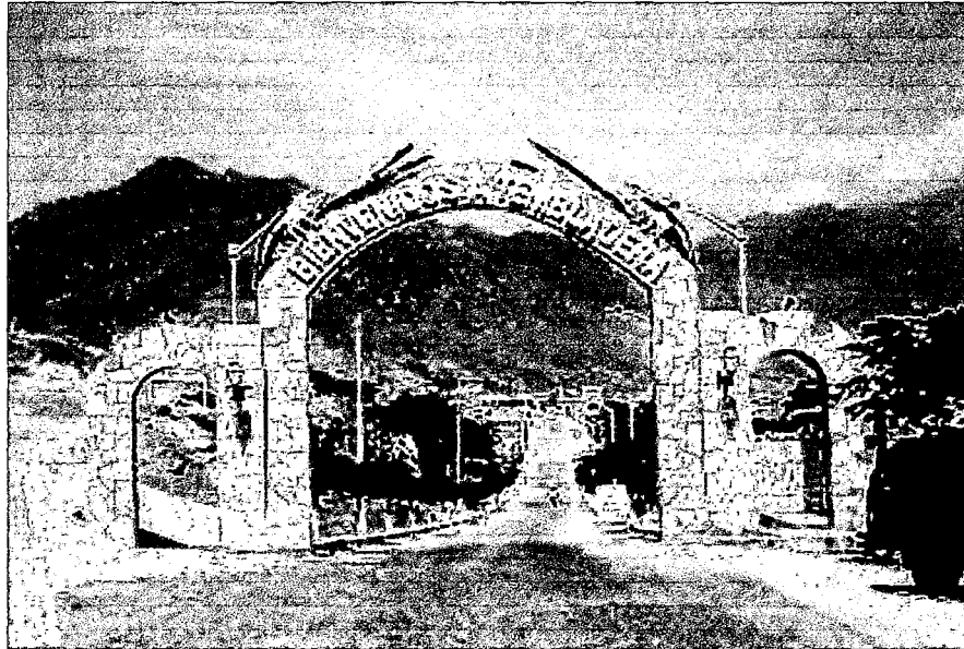
Foto N°1: Portada de Bienvenida a Tembladera capital del distrito de Yonan
