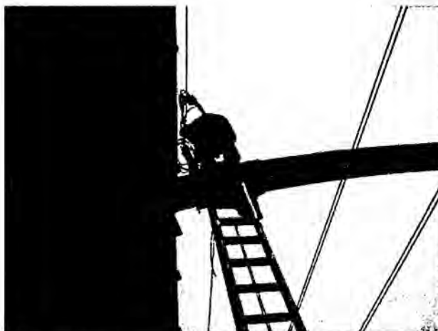
Foto Referencial: Acceso para instalación de accesorios en el extremo de la cobertura.
