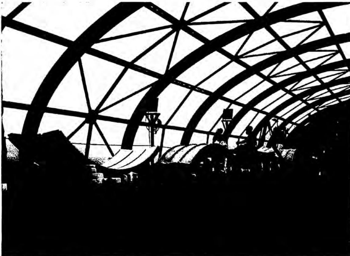
Figura1.2.1.4 –Fotografía - Instalación de Cubierta de Techo (Fuente: Tramo 2)
