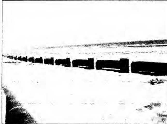
Figura N° 26: Instalación de lastres de concreto
