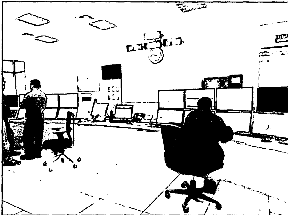
FIGURA N° 4.10: SALA DE CONTROL DE LA C.T. CHILCA1
