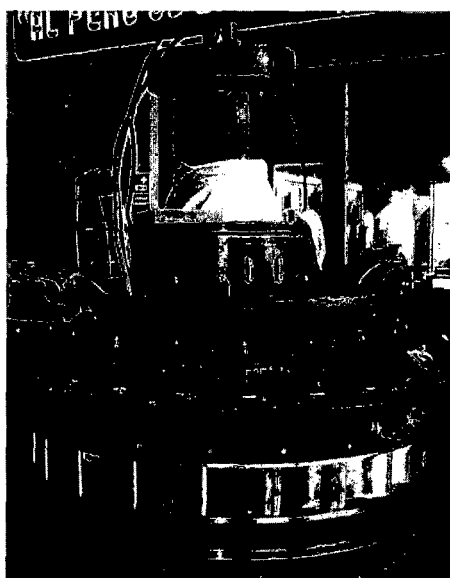
Foto N° 4.2. Turbina Francis de eje vertical
