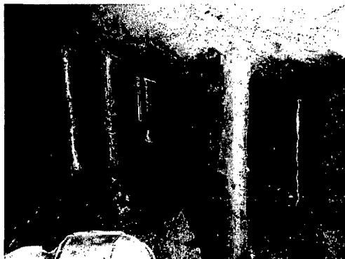
Fotos 5.5 y 5.6 Evaluación del estado del predistribuidor y caracol luego de la metalización efectuada y operación anual de las turbinas N° 1 (izq.) y N° 2 (der.)
