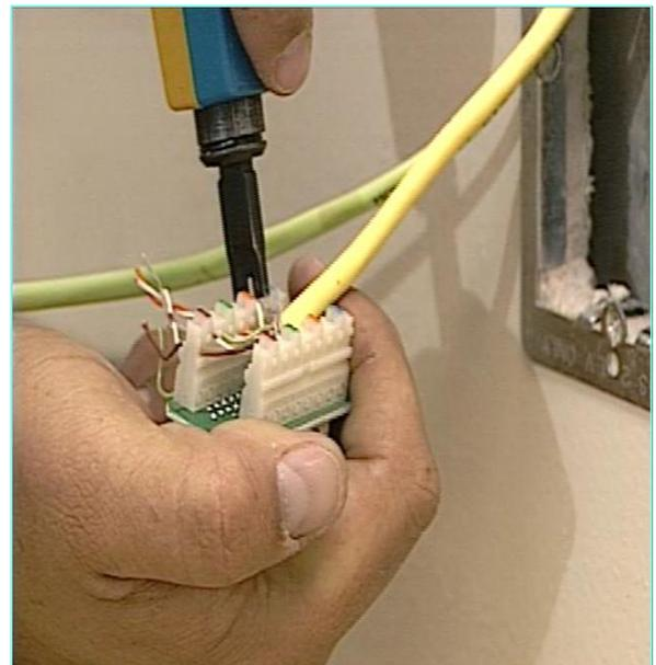
**- Usando Jack a presión para el Patch Panel en una Red Lan Básica**
