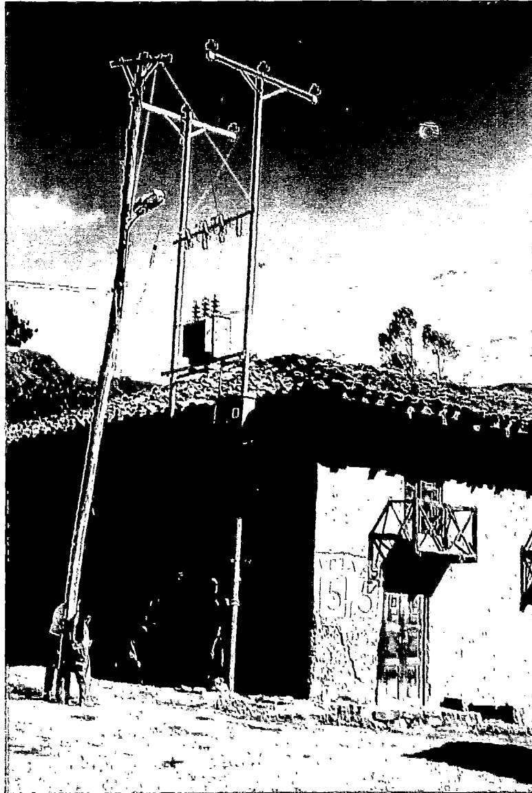
Derivación de la Línea Primaria a la Localidad de Quinuabamba, Distrito de Quinuabamba donde la SAB es Tubular.
