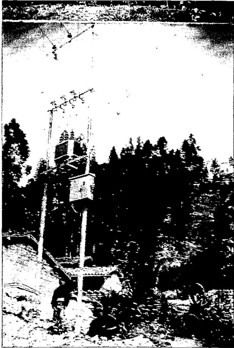
Derivación de la Línea Primaria a la Localidad de Cachipampa, Distrito de Parobamba donde la SAB es Tubular.
