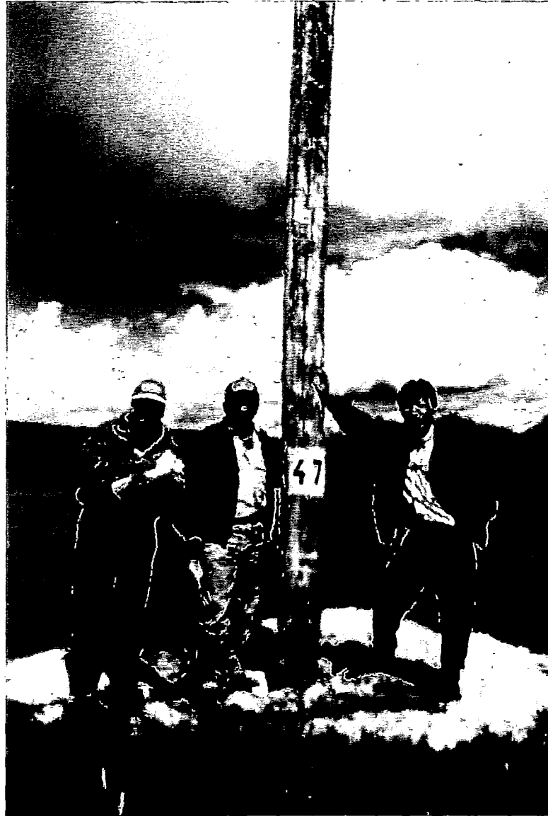
Tramo de la Línea Primaria donde el poste N° 47 se observa al conductor de bajada a tierra cortado. Supervisores de la Región Chavin e Hidrandina-Huaraz.
