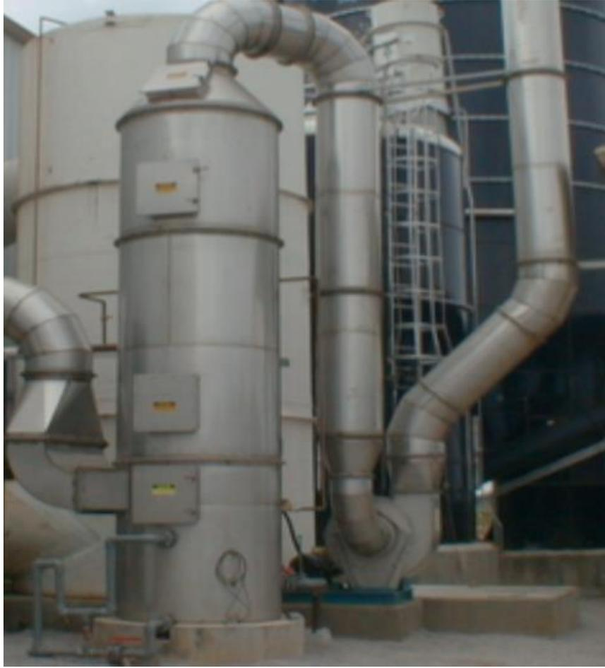
**Figura N° 17 : LAVADOR DE GASES**
