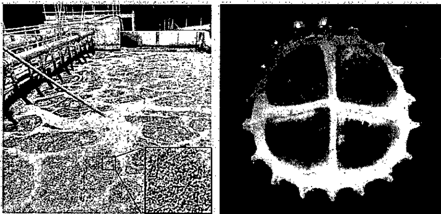
FIGURA N° 5. REACTOR MBBR AERÓBICO CON CRECIMIENTO DE BIOPELÍCULA
