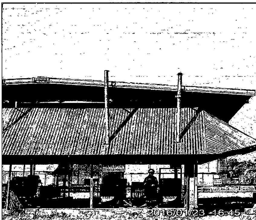
Emissiones Gaseosas Motogenerador 6-1305 Zona Industrial-Estación Morona
