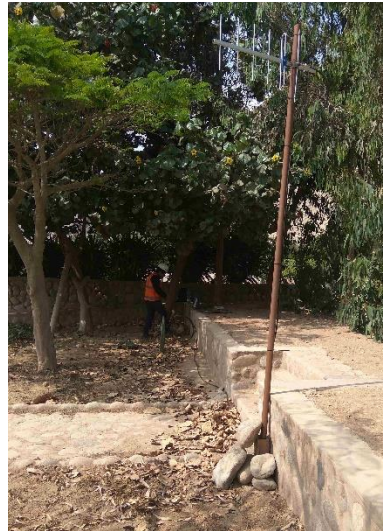
Figura N° 5. 14 Instalación de antena yagi y medición de radioespectro en la estación PP-03
