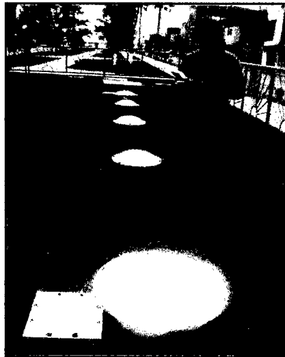
Fotografía N° 2.6: PTAR Av.Grau-100m 3 /día- Proceso de Lodos Activados
