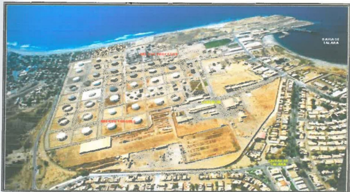
Figura N° 8: Toma Aerográfica de la Refinería Talara
