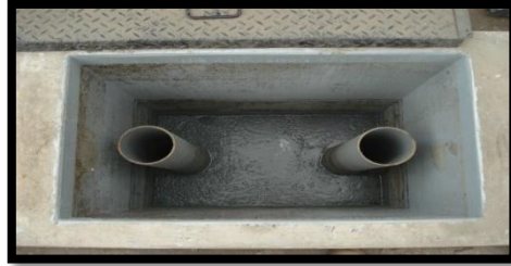
Figura № 4 CÁMARA DE SEDIMENTACIÓN PRIMARIA
