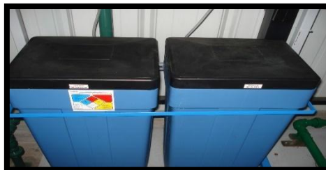
Figura № 9 TANQUES DE REACTIVOS
