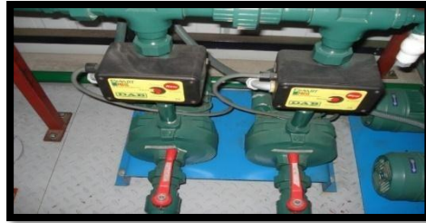
Figura № 11 BOMBAS DE FILTRO Y KIT DE PRESIÓN
