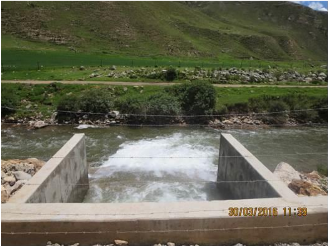
Figura N°54. Canal de demasías o aliviadero-tramo final descarga al río.
