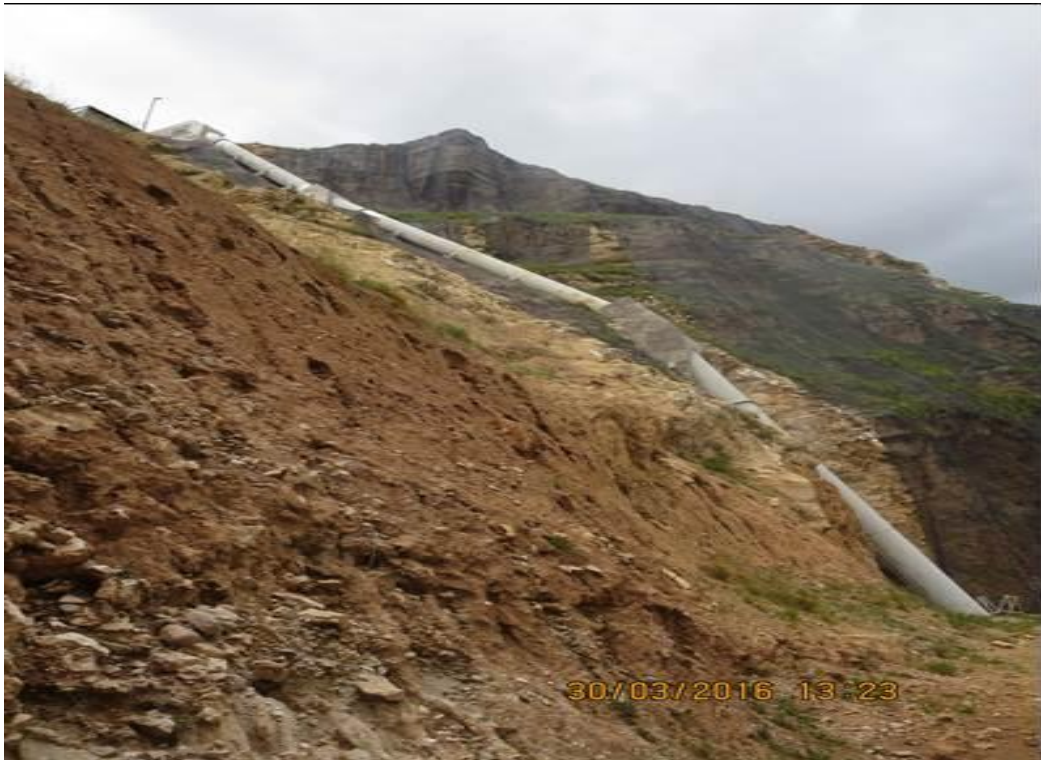
Figura N°62. Tubería de presión-vista lateral y geo mallas para evitar caída de rocas
