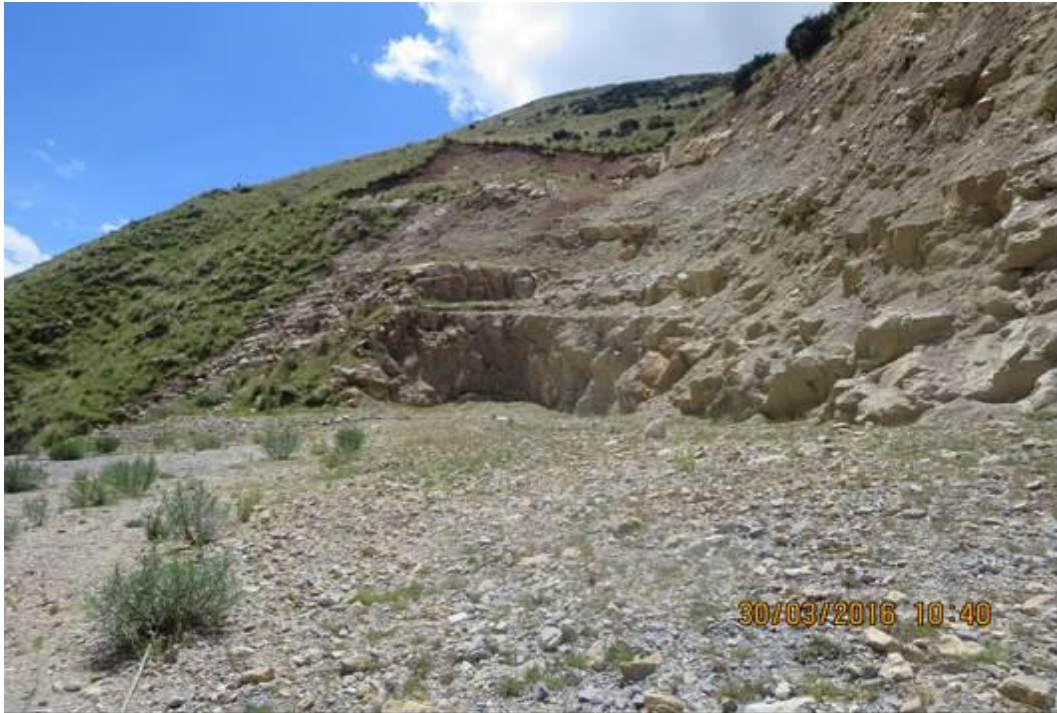
Figura N°42. Tramo N°03- Ingreso de Canal de Conducción del tramo N°03
