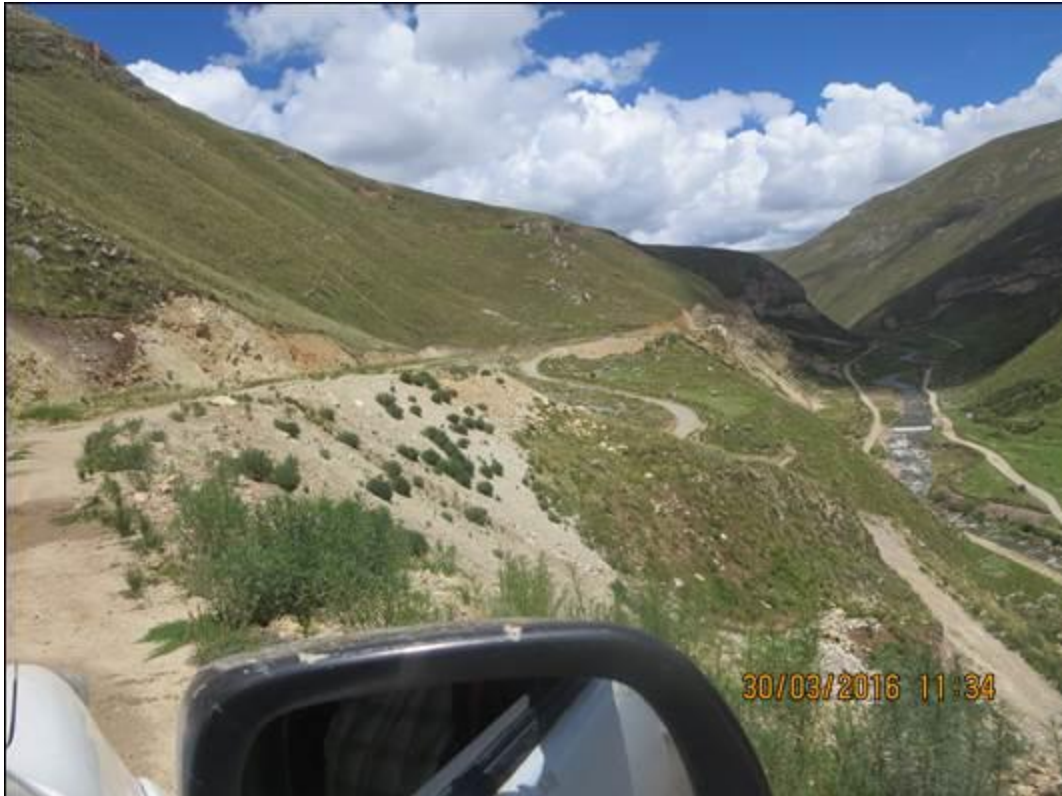
Figura N°46. Tramo N°03- Trayecto hacia cámara de carga.
