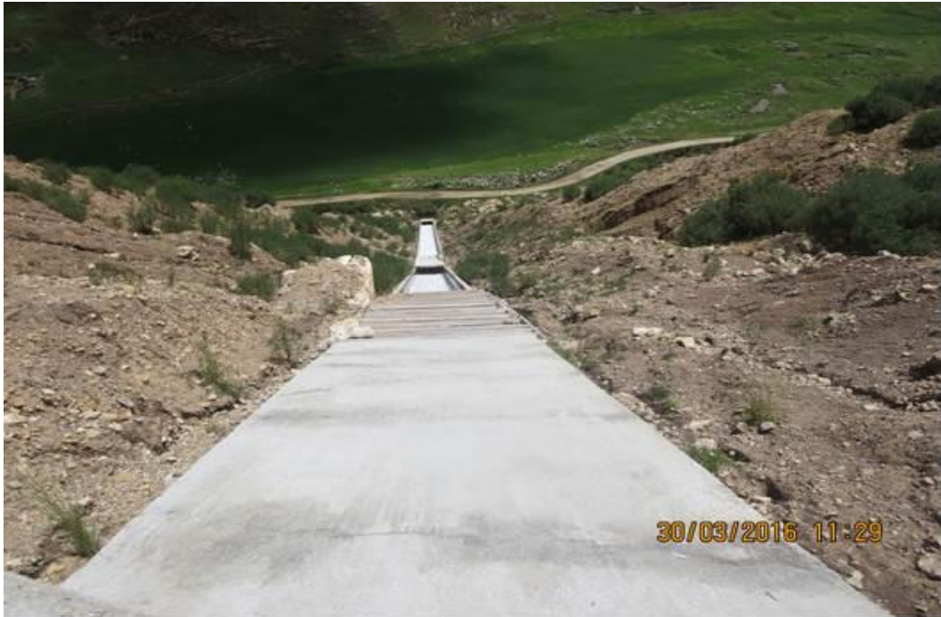
Figura N°52. Canal de demasías o aliviadero-tramo superior.
