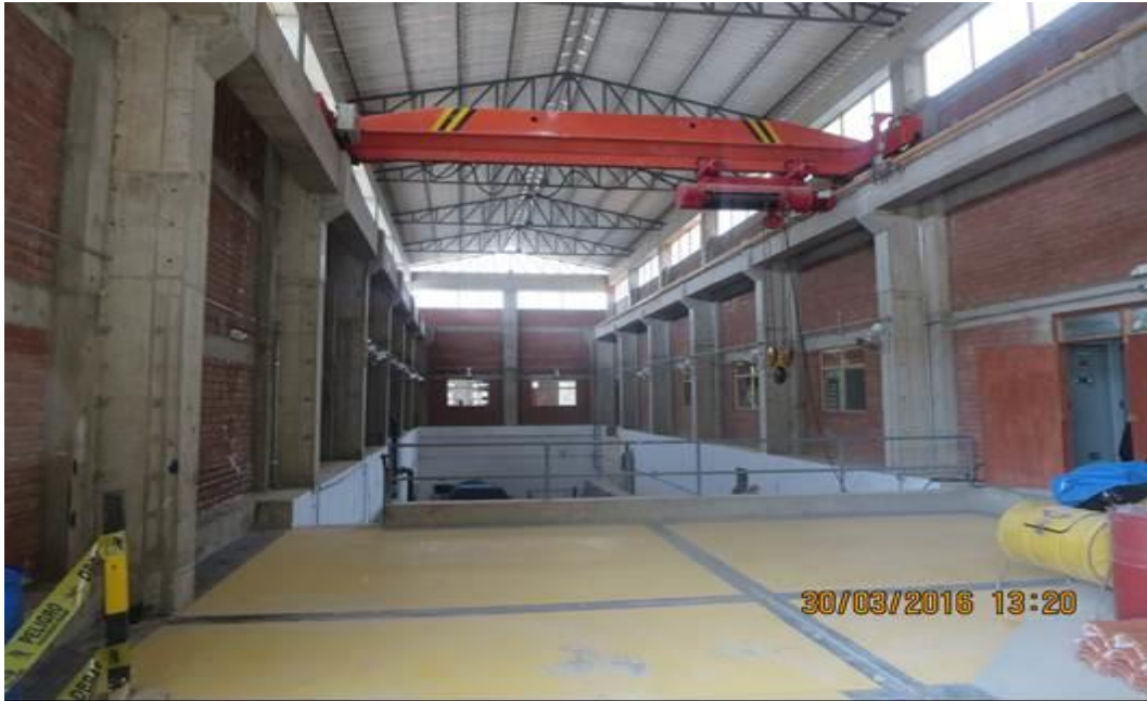
Figura N°66. Puente Grúa de 10 Tn
