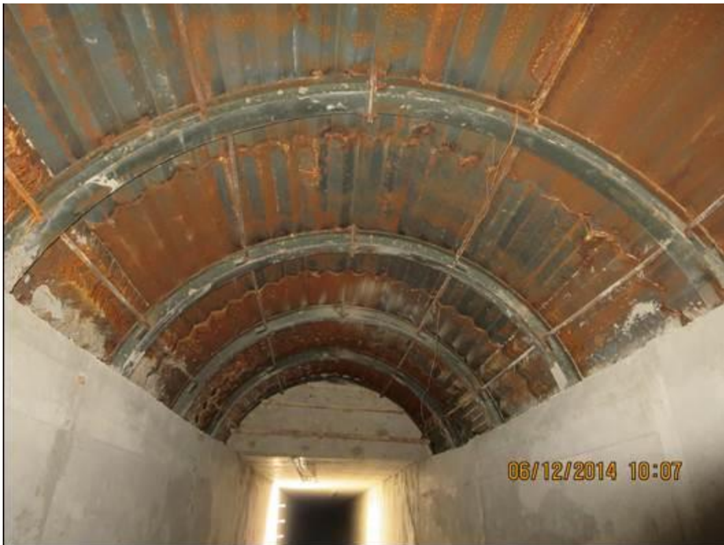
Figura N°43. Tramo N°03- Canal de Conducción –Vista Interior.
