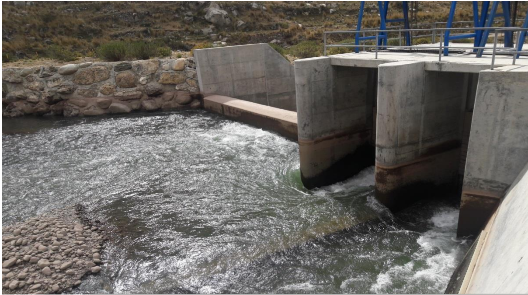
Figura N°08.Solera de Captación.
