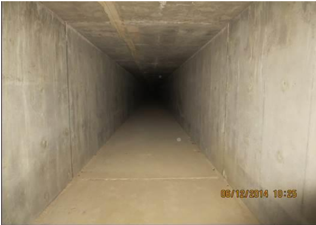
Figura N°39. Tramo N°02- Canal de Conducción –Interior.
