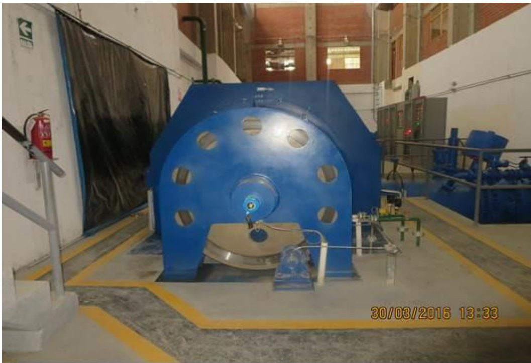
Figura N°73. Volante del Generador N° 01.
