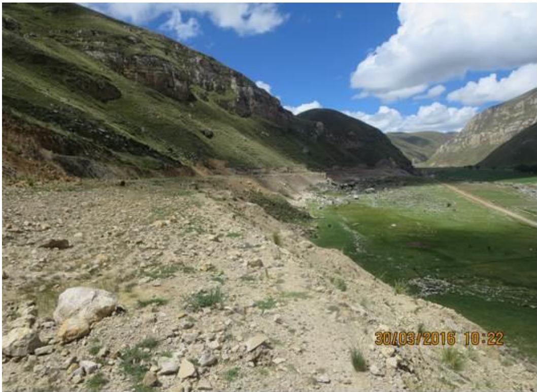
Figura N°41. Tramo N°02- Canal de Conducción hacia el tramo N°03
