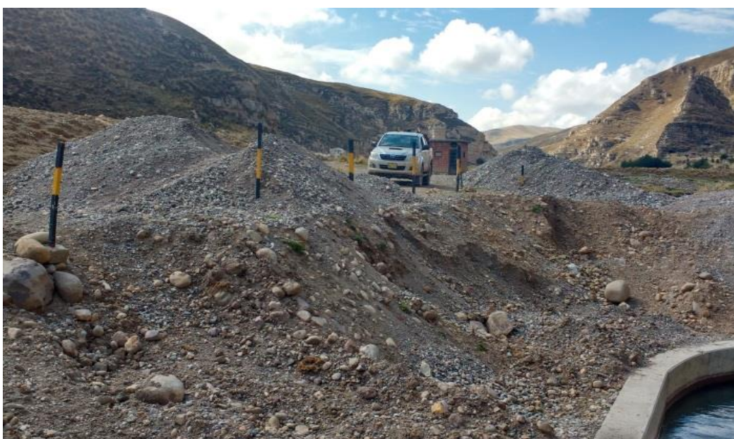
Figura N°31. Hormigón extraído de la poza de decantación y Solera de Captación
