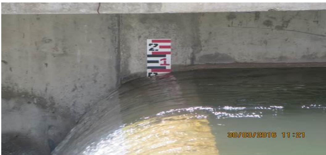
Figura N°49. Regla para medición de rebose de cámara de Carga.
