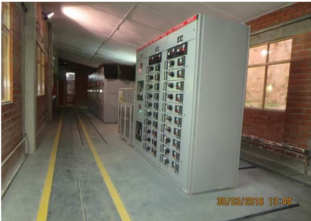
Figura N°89. Mandos de Servicios Auxiliares. 380V y 220V
