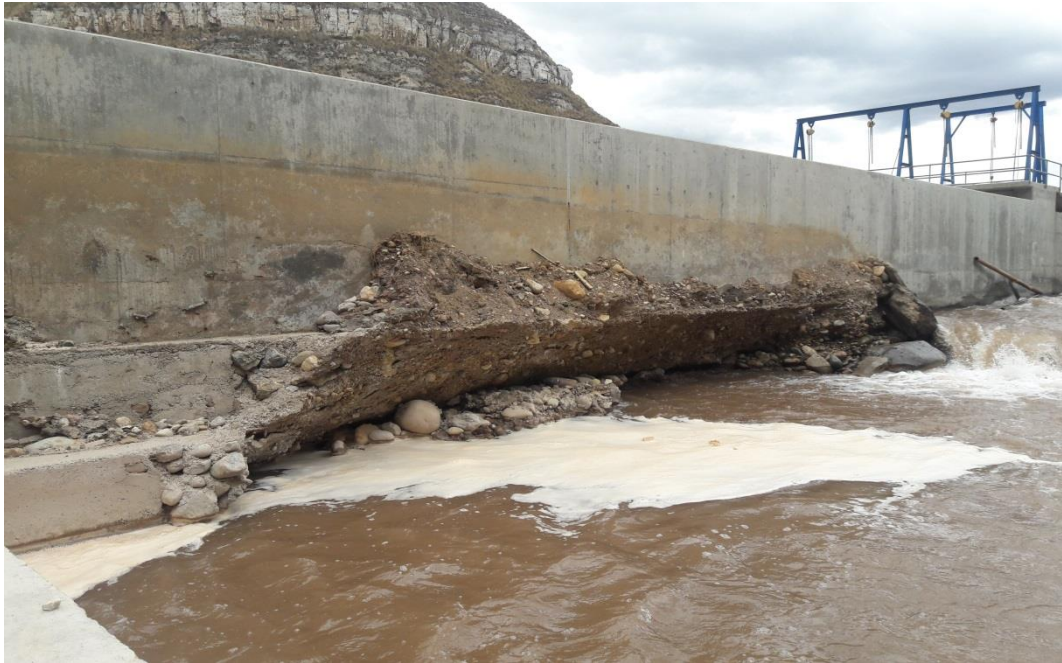
Figura N°25. Muro de Encauzamiento-Enero 2018.
