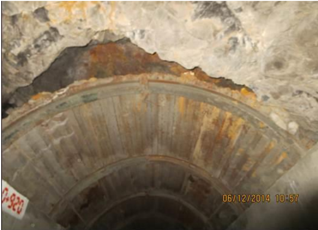
Figura N°38. Tramo N°02- Canal de Conducción –Túnel N°02.
