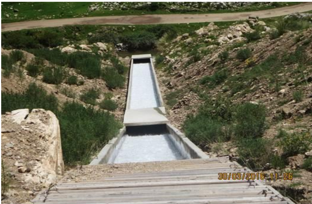
Figura N°53. Canal de demasías o aliviadero-tramo inferior.
