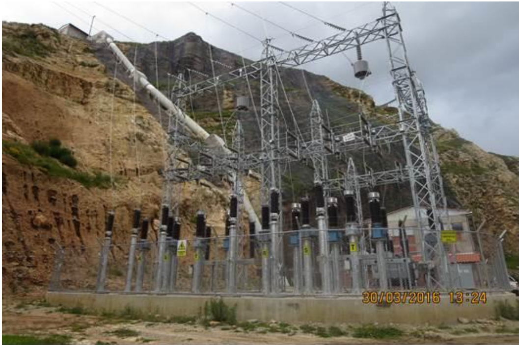
Figura N°92. Trampa de Onda
