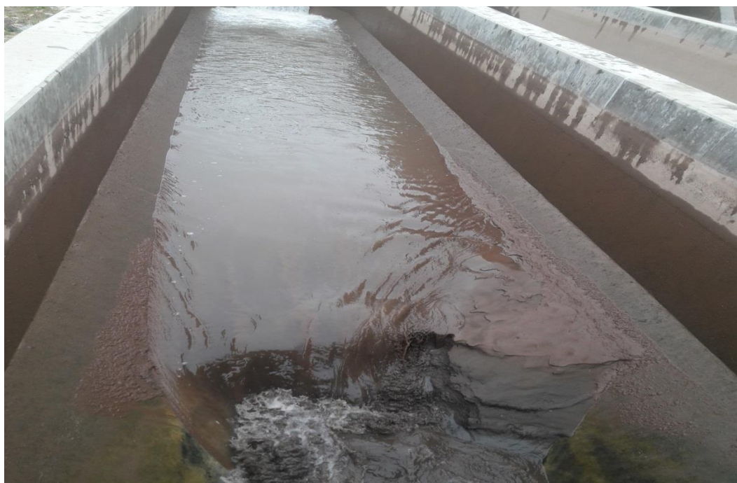
Figura N°12.Desarenador.
