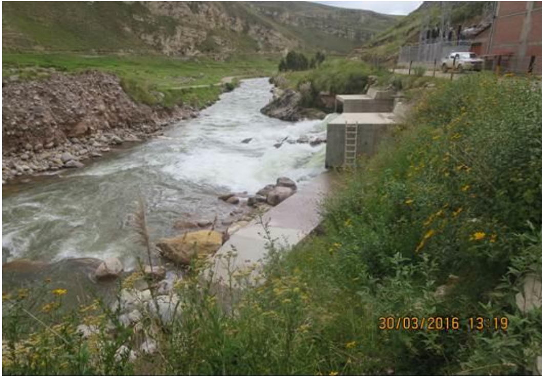
Figura N°82. Canal de descarga de aguas turbinadas de los generadores N°01 y N°02.
