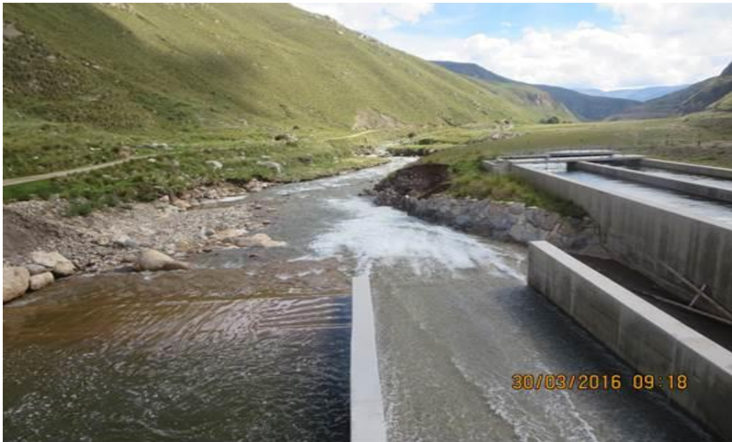
Figura N°24. Muro de Encauzamiento-Marzo 2016.
