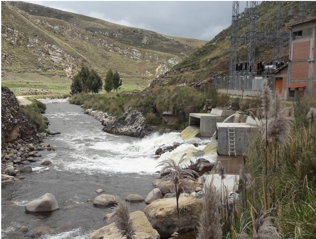
Figura N°18. Canal de Descarga de Agua Turbinada.
