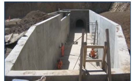
Acabados en la cámara de carga
