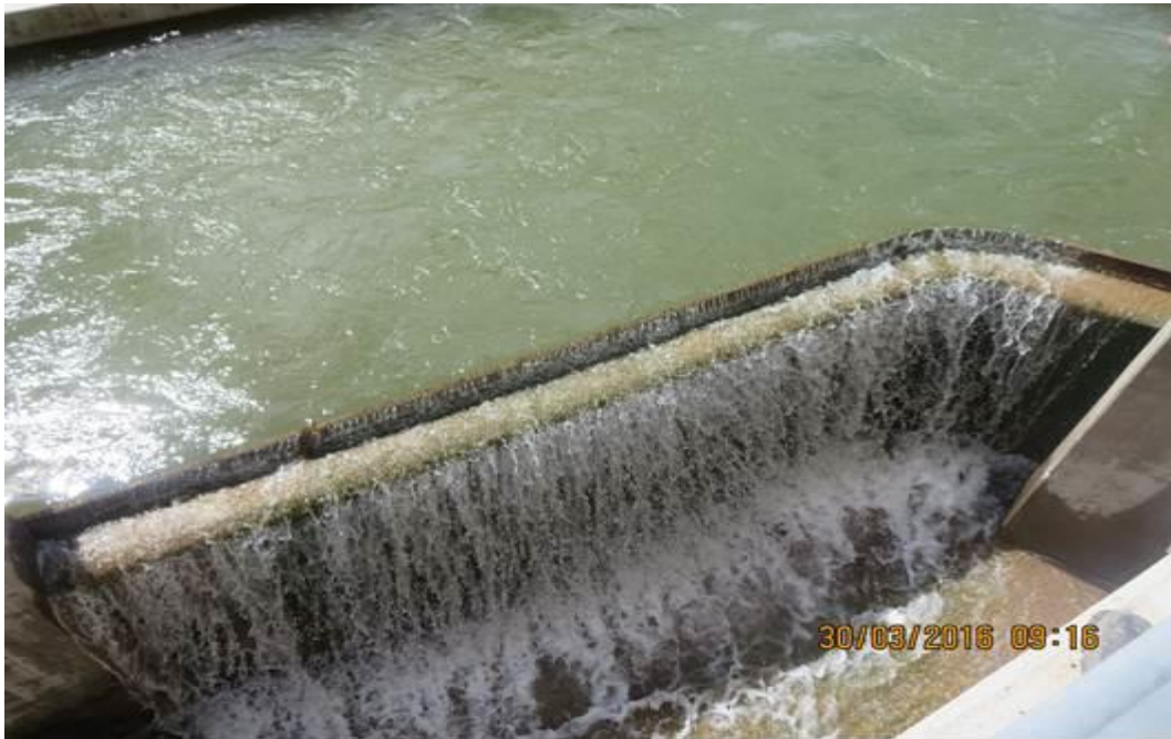
Figura N°28. Rebose de la Poza de Desripeado.
