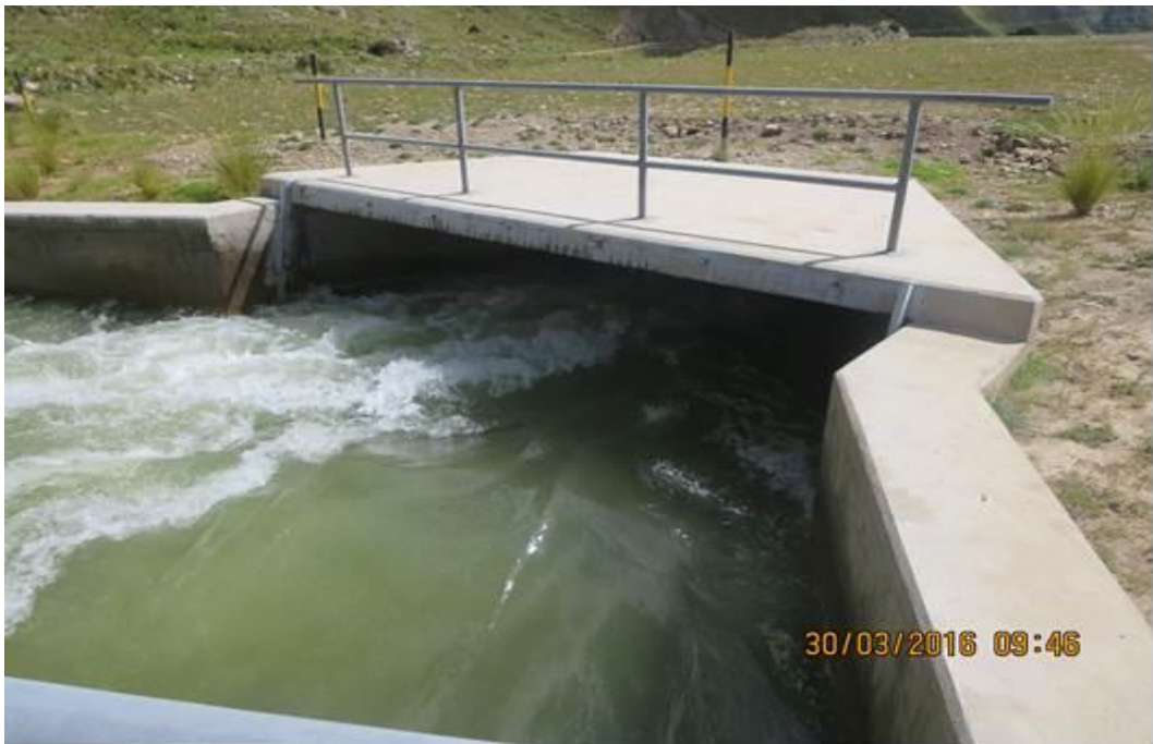
Figura N°33. Tramo N°01-Ingreso de Agua a Canal de Conducción.
