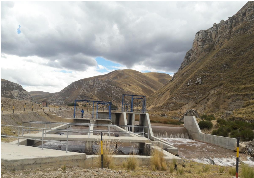
Figura N°06. Estructura de Captación o Bocatoma Fuente: Propia
