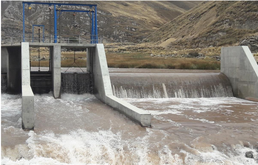
Figura N°07. Barraje. Fuente: Propia
