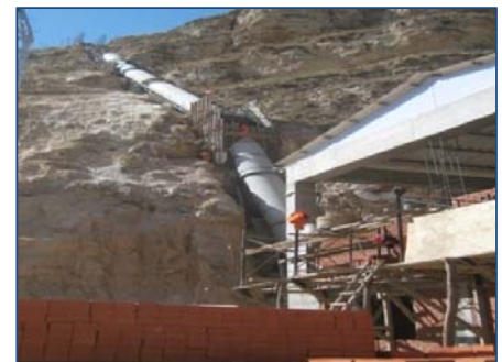
Vista de la Tubería Forzada-Casa de Máquinas
