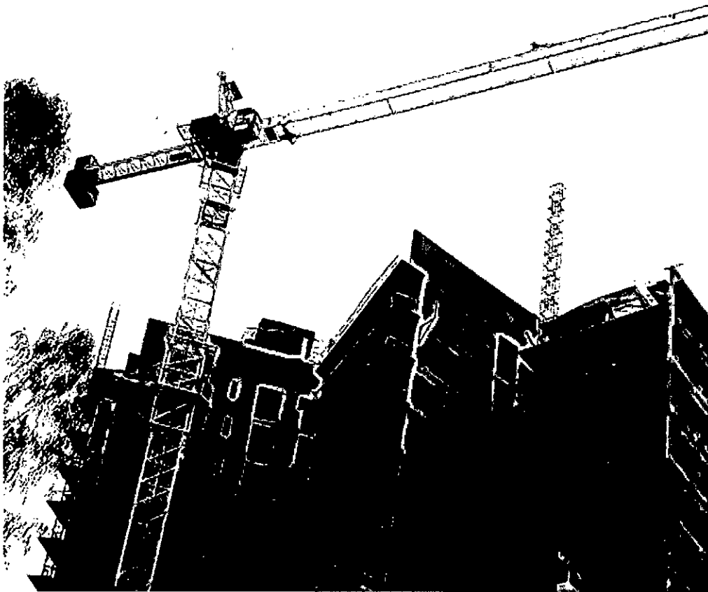
FIGURA N° 5.4 : GRÚA TORRE MARCA PECCO SK 135.
