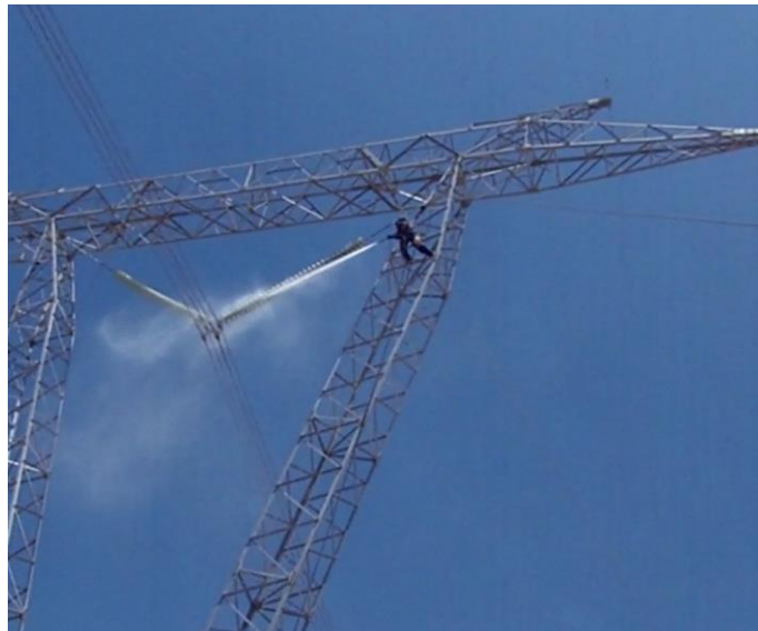
Figura 3b: Únicamente desde la Segunda Posición de lavado, personal puede lavar las cadenas en V.
