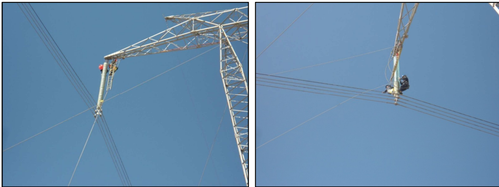
Foto 7 y 8: Toma de muestra en torre 720 de L-5032
