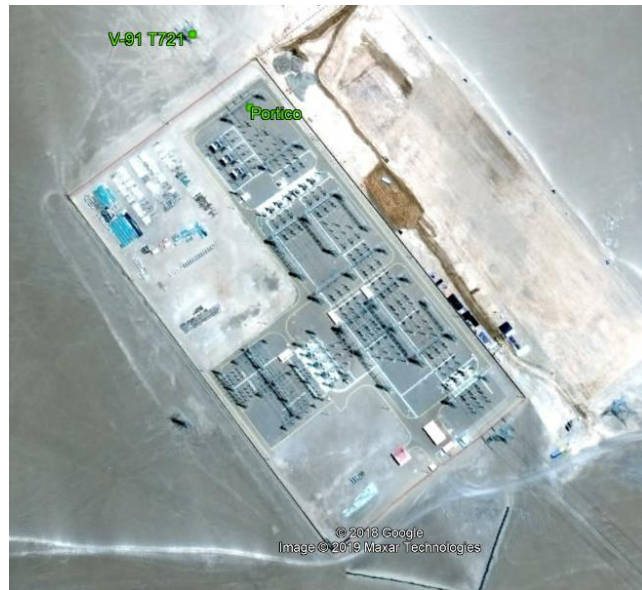
Figura N° 64. Subestación eléctrica de transmisión Poroma 500kV/220kV. Fuente: Propia.
