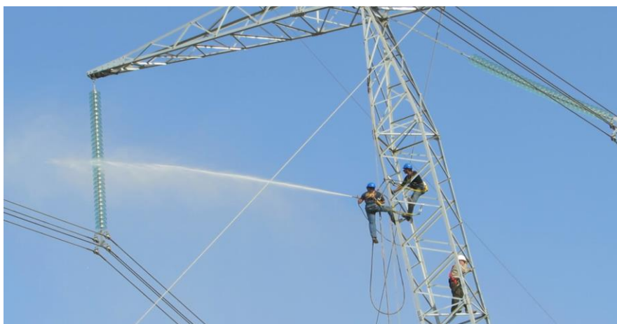
Figura N° 46. Lavado de aisladores en torre de suspensión.
