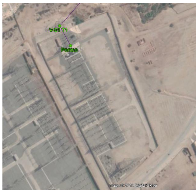
Figura N° 63. Subestación eléctrica de transmisión Chilca 500kV. Fuente: Propia.
