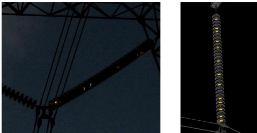
Figura N° 58. Nivel de efluvo 3. Fuente: Propia
