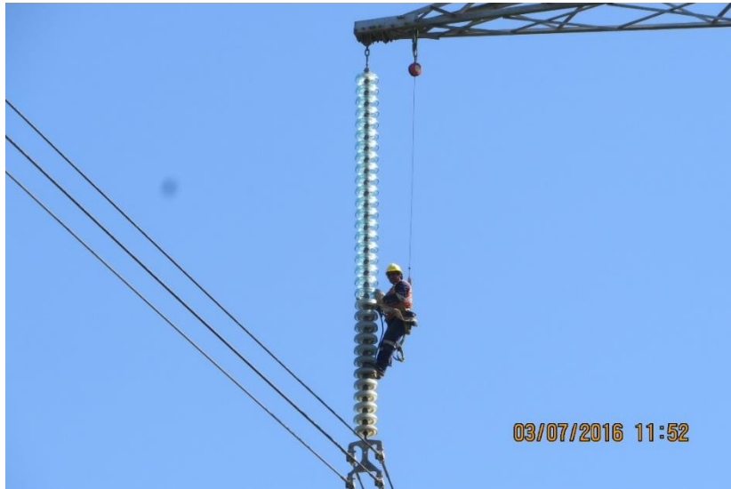
Figura N°44. Limpieza manual de aisladores en una torre de suspensión. Fuente: Propia.
