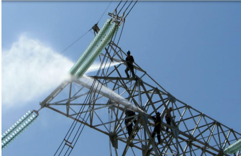
Figura N° 47. Lavado de aisladores en torre de anclaje. Fuente: Propia.
