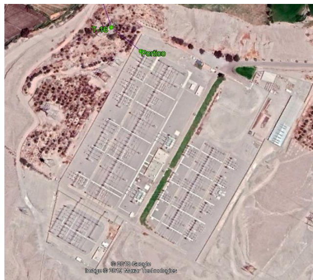
Figura N° 67. Subestación eléctrica de transmisión Montalvo 500kv/220kv. Fuente: Propia.
