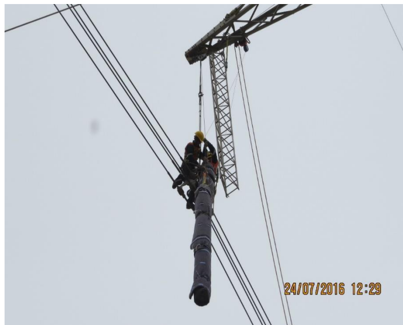
Figura N° 49. Cambio de aisladores parte 2. Fuente: Propia.
