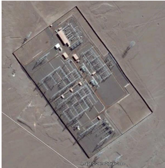
Figura N° 66. Subestación eléctrica de transmisión San José 500kV/220kV Fuente: Propia
