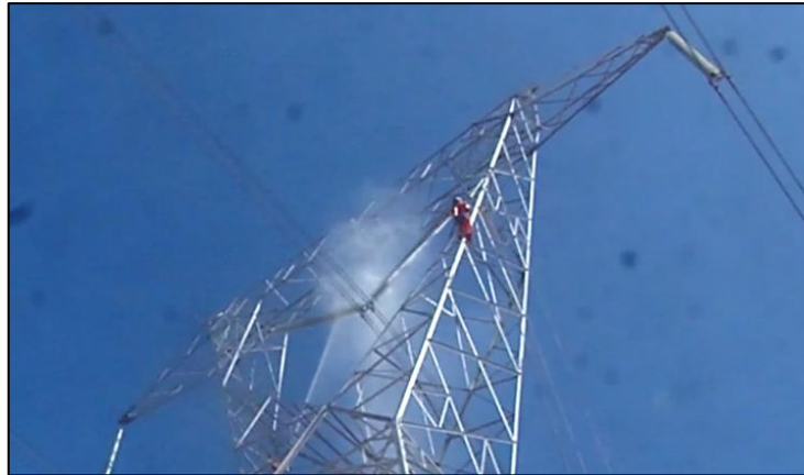
Figura 4: Para el lavado de las cadenas en "V" el operador 1 Y2 se posiciona en la zona de la unión entre las ventanas inferiores y superiores de las torres autosoportadas.
