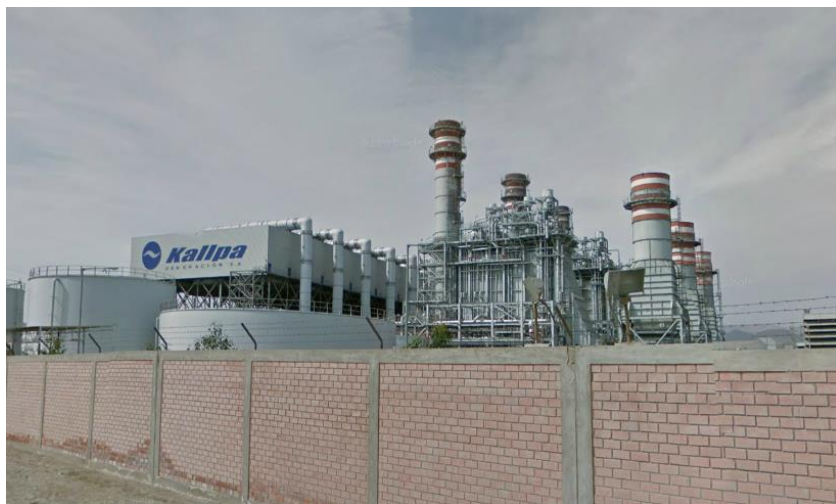
Figura N° 38. Contaminación por Lluvia ácida. Fuente: Propia.
