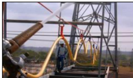
Instalación de LV y aseguramiento de la manguera a esta.
