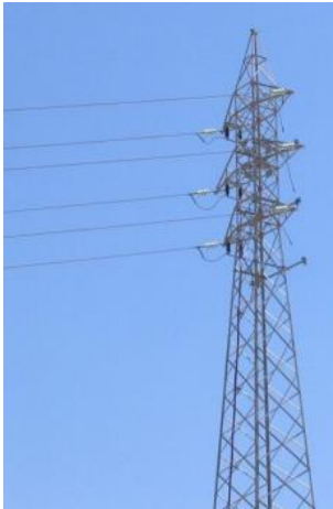
Figura N° 18. Apoyo de fin de línea. Fuente: Análisis estructural de una torre de alta tensión, Leganés, 2014, universidad Carlos III de Madrid.
