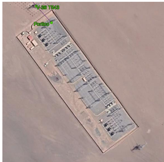
Figura N° 65. Subestación eléctrica de transmisión Ocoña 500kV. Fuente: Propia.
